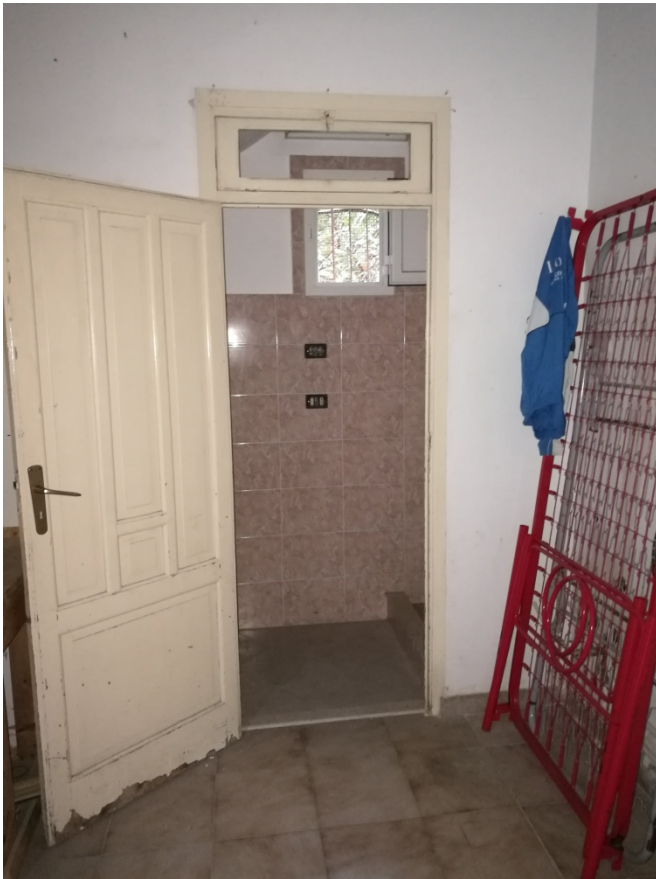
FOTO N.6 PORTA CHE CONDUCE AL WC DOCCIA
