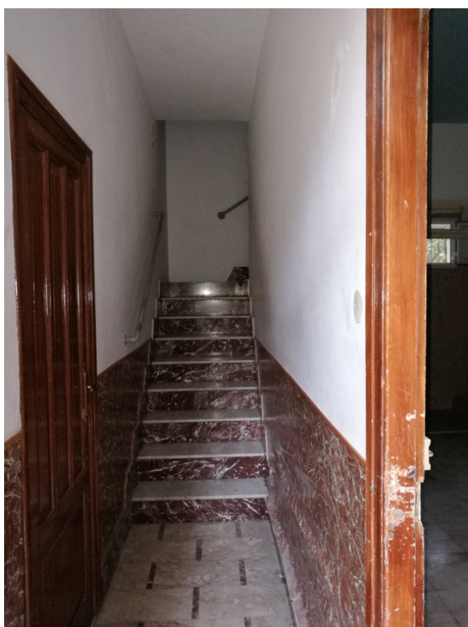
FOTO N.3 SCALA DI ACCESSO CONDOMINIALE ED INGRESSO AL LOCALE BOX
