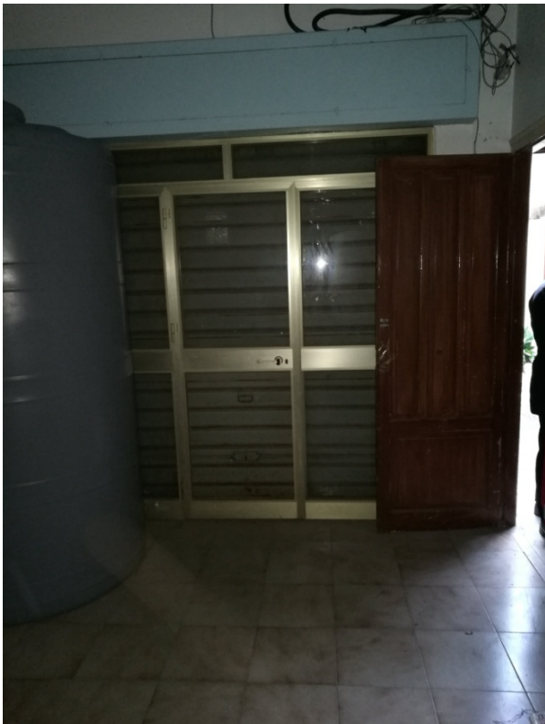
FOTO 5 INTERNO DEL LOCALE BOX.
