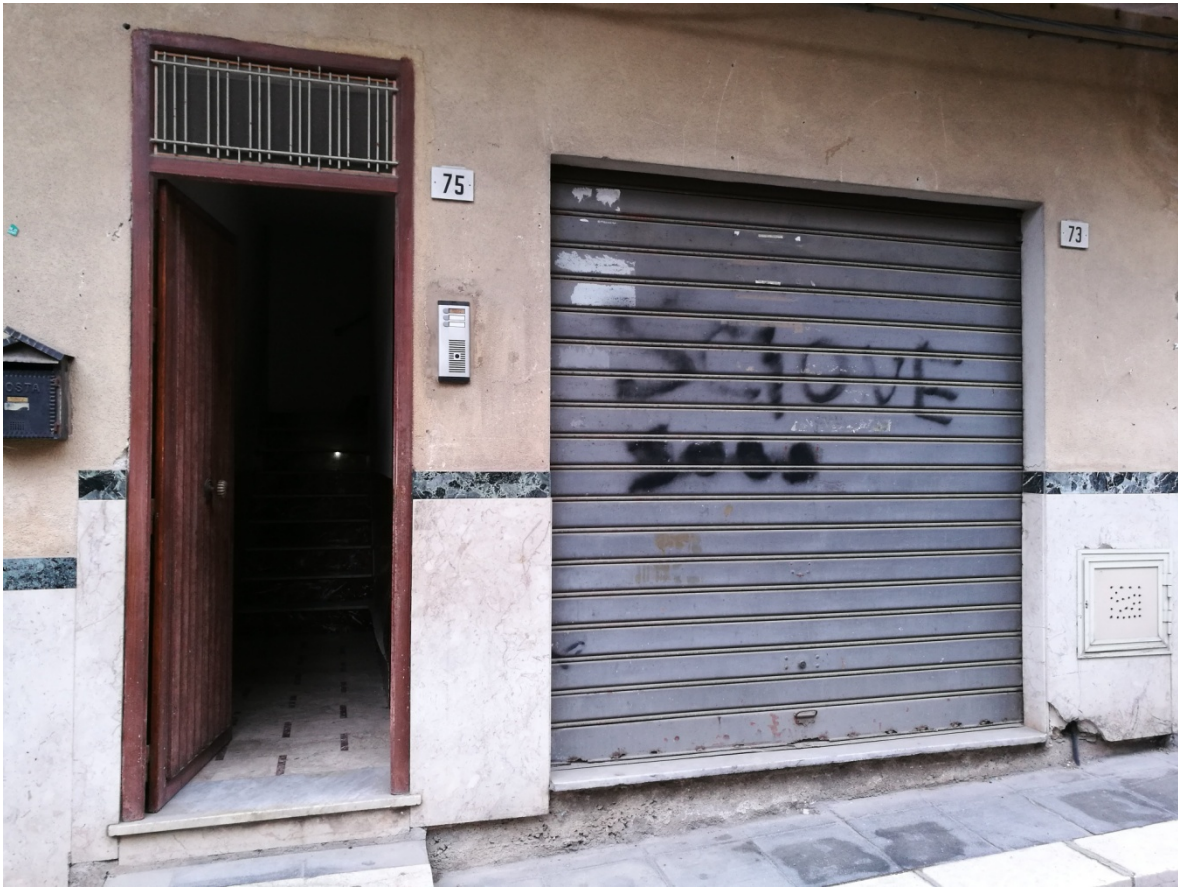
FOTO N.4 PORTONCINO DI ACCESSO CONDOMINIALE ED INGRESSO AL LOCALE BOX
