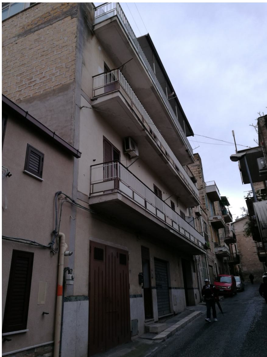
FOTO N.1 PROSPETTO DELLA PALAZZINA DOVE E' UBICATO IL LOCALE BOX A PIANO TERRA
