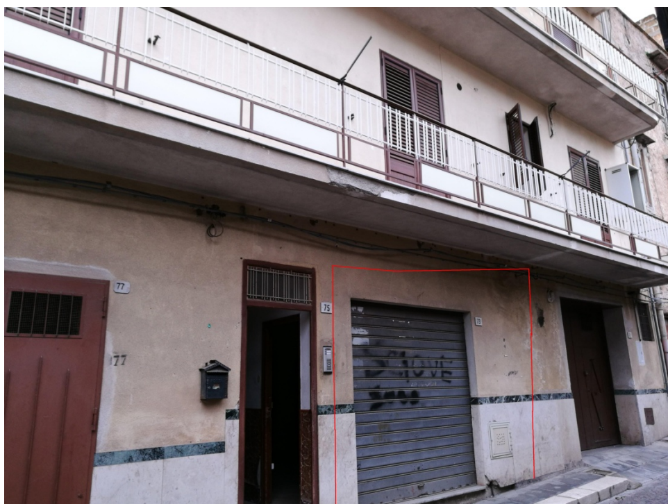
FOTO N.2 PROSPETTO E APERTURA SU STRADA VIA GIUSEPPE VERDI N.73
