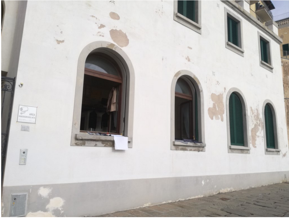
FOTO 1: VISTA ESTERNA FABBRICATO
