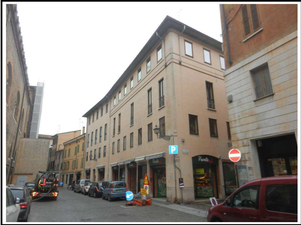
Foto 1 Prospetto dalla Via Giustizati
