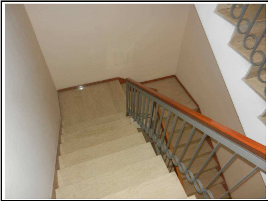
Foto 7 Vano scala comune
