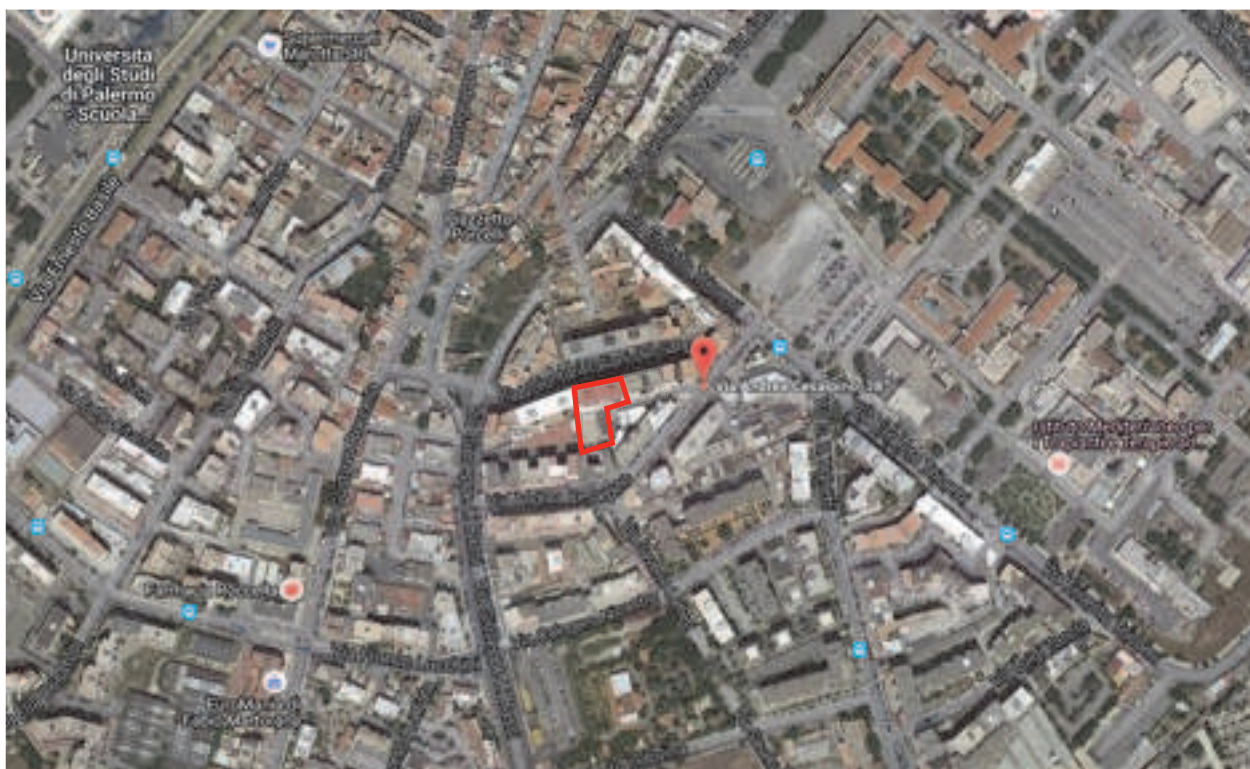
Foto 1: Inquadramento urbanistico dell'immobile
