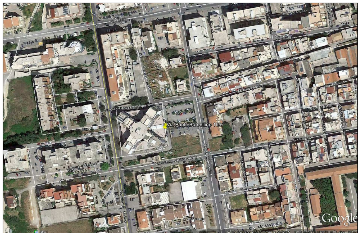
Foto 2 - Particolare della zona con evidenziato l'edificio
