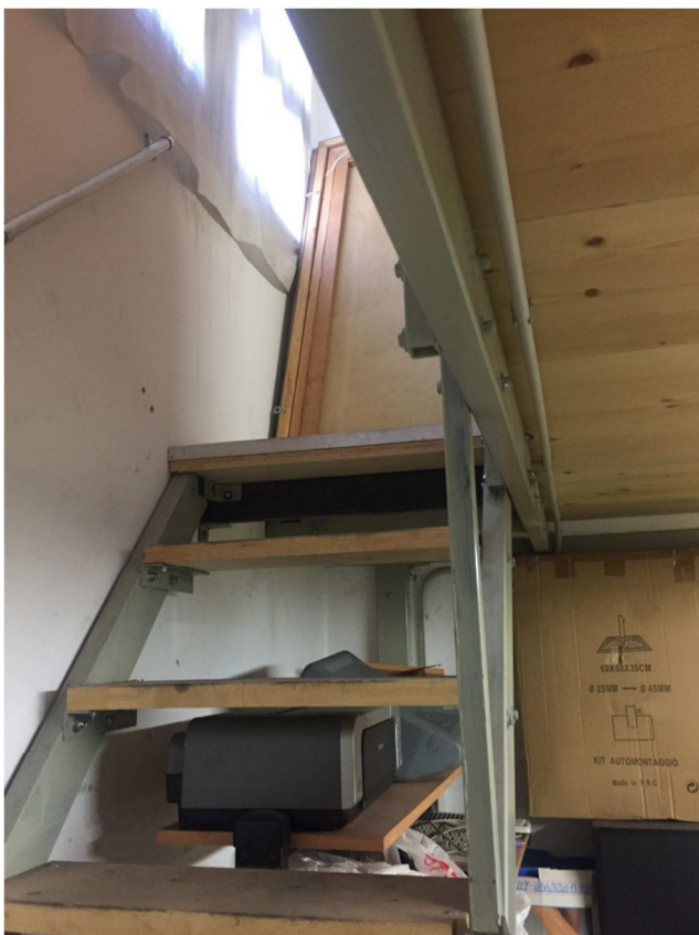
Scala accesso al soppalco
