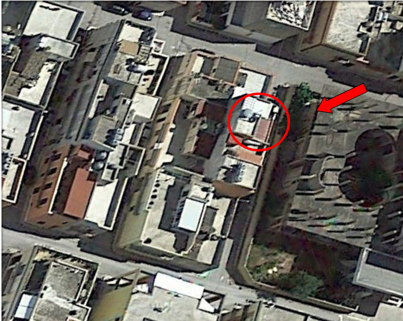
VISTA DALL'ALTO DELL'IMMOBILE
