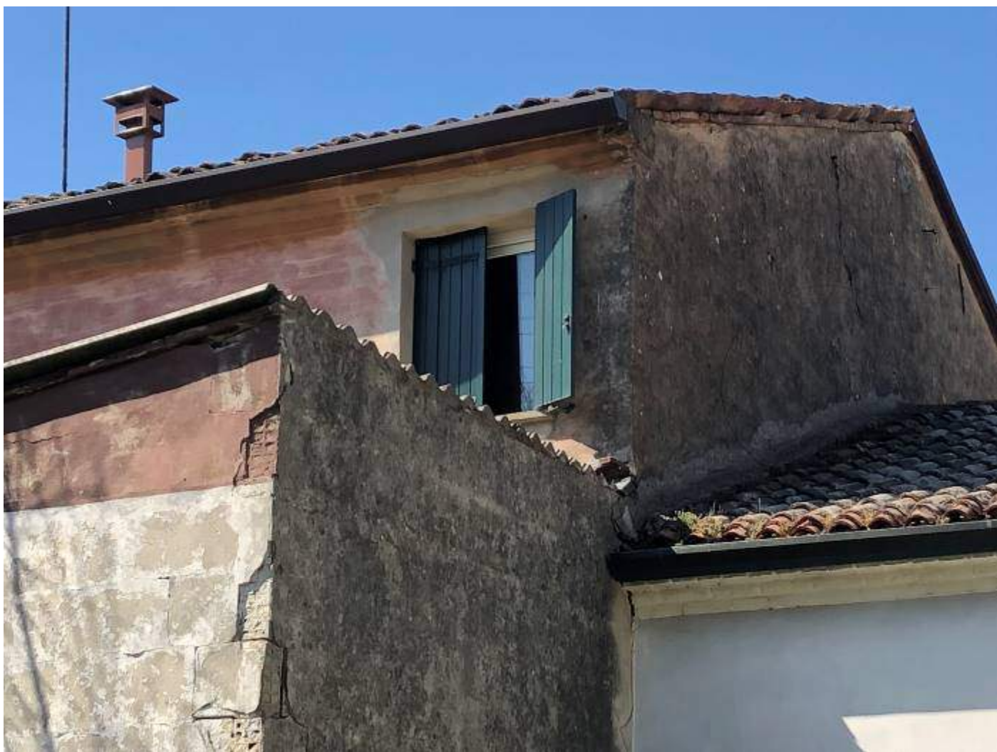
Particolare finestra sottotetto ( inserimento finestre senza modifica andamento falda )
