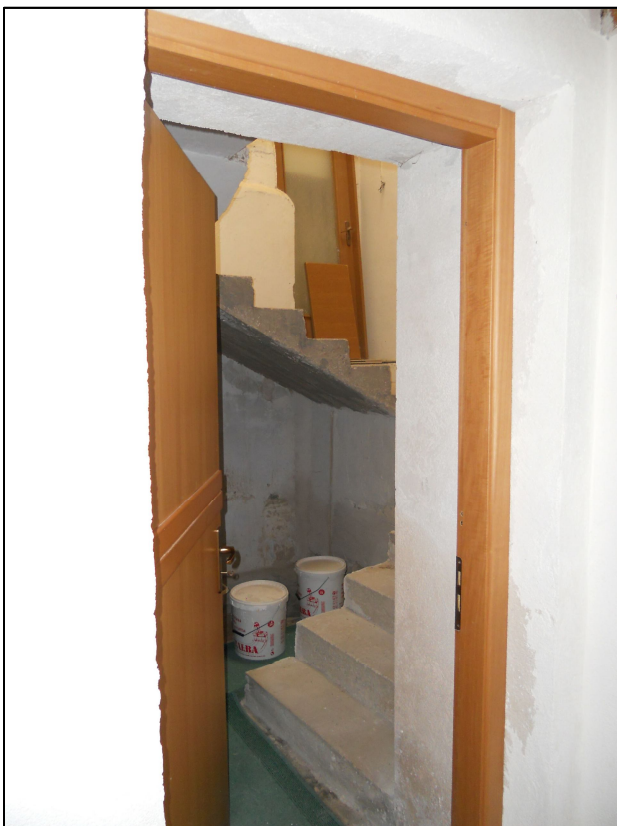
FOTO 22 – Ingresso del vano scala
