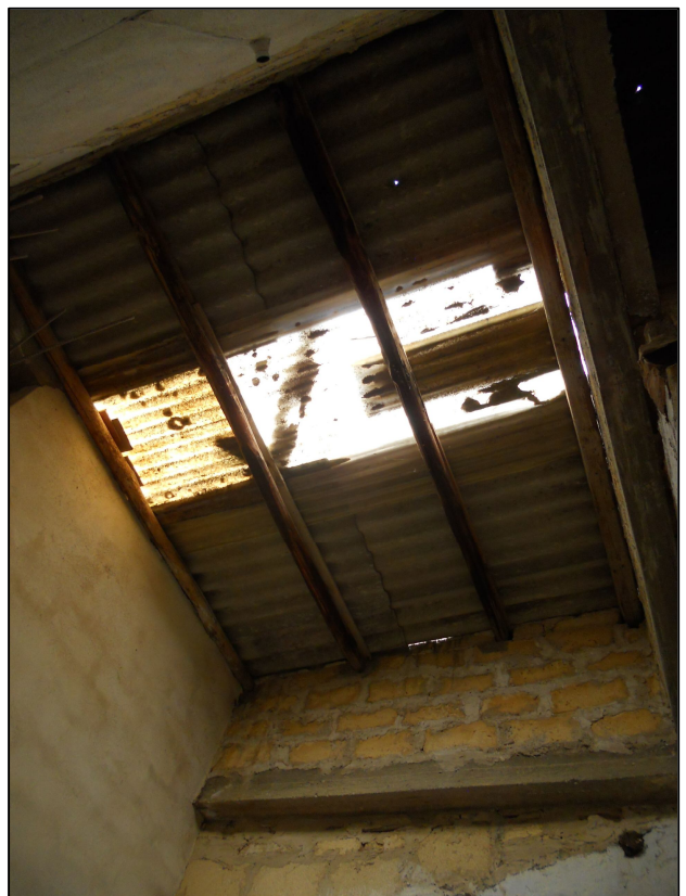
FOTO 23 – Copertura del vano scala
