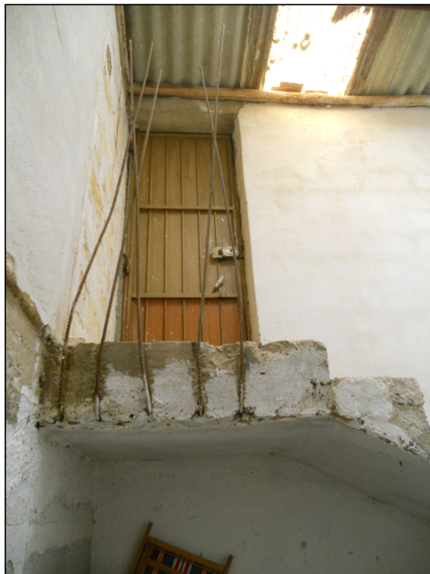
FOTO 25 – Accesso a copertura e sottotetto
