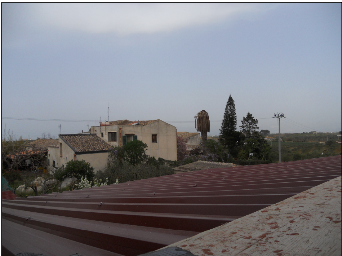
FOTO 27 – Abitazione – Falda di copertura
