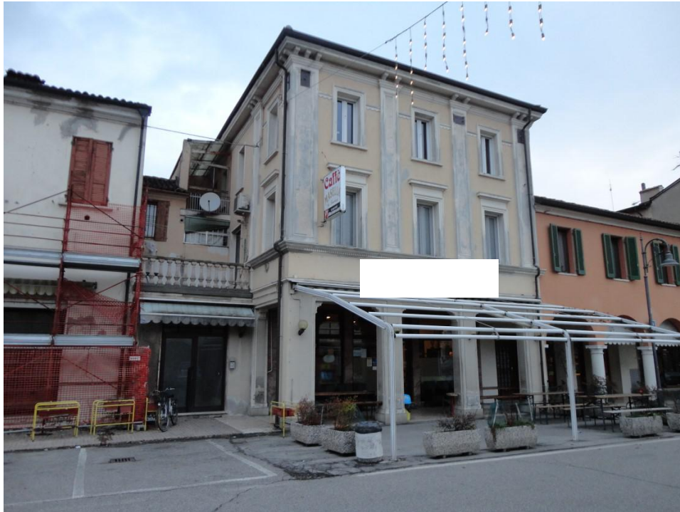
FOTO 1 – VISTA DA PIAZZA MATTEOTTI
