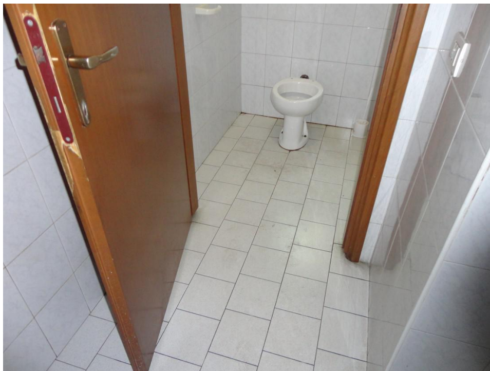
FOTO 7 – BAGNO PIANO TERRA
