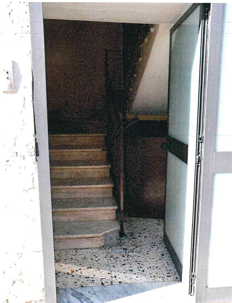
FOTO N. 3 PARTICOLARE INGRESSO CONDOMINIALE DEL FABBRICATO
