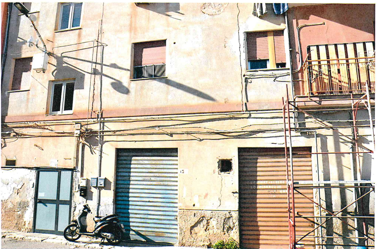
FOTO N. 2 PARTICOLARE DEL PROSPETTO SU VIA ROMA IN CORRISPONDENZA DEL PIANO PRIMO
