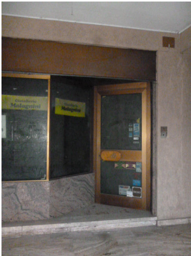
FOTO 4 – Negozio Sub. 7: porta di accesso
