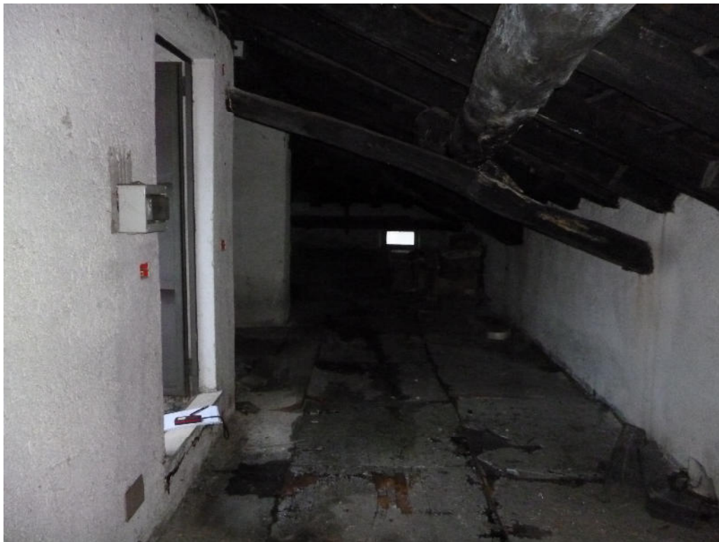
FOTO 10 – Sottotetto Sub. 10: interno, a sinistra porta di accesso al terrazzo
