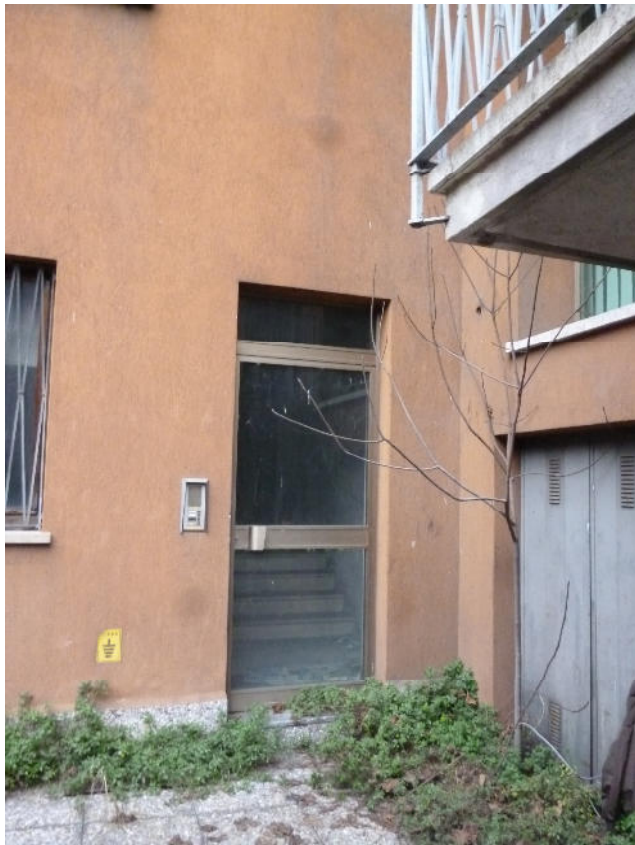
FOTO 8 – Porta di accesso al vano scale comune
