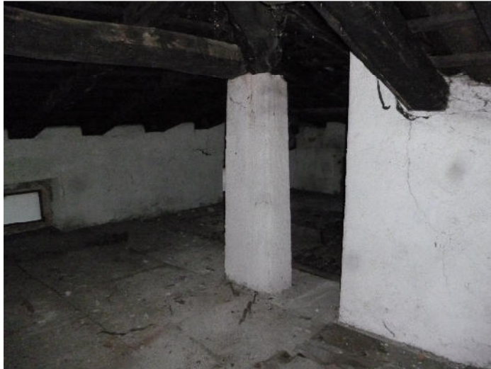
FOTO 12 – Sottotetto Sub. 10: interno, particolare
