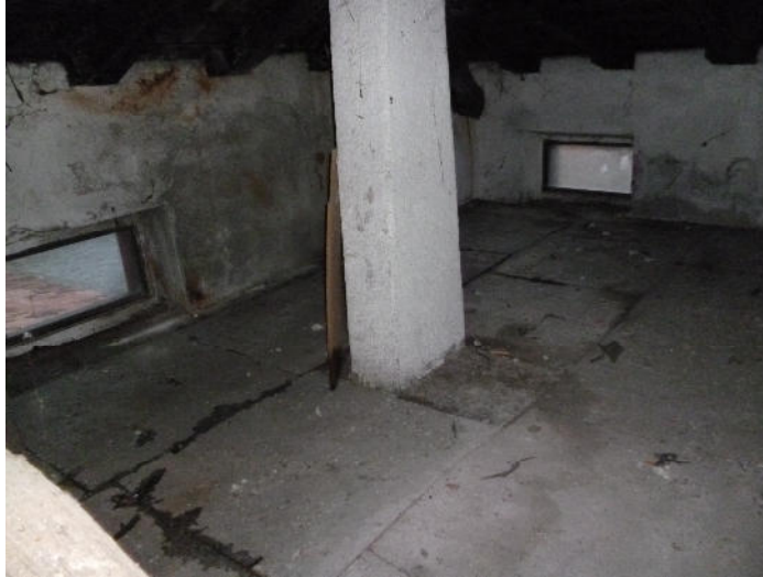
FOTO 11 – Sottotetto Sub. 10: interno, particolare
