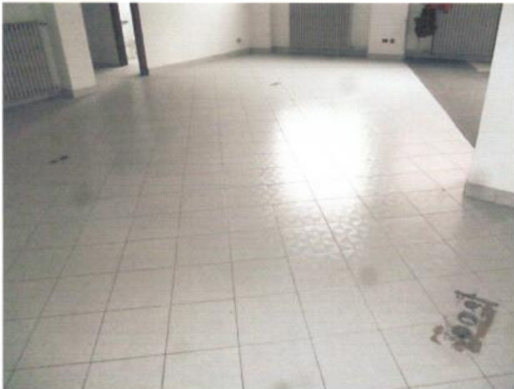
FOTO 7 – Particolare pavimentazione ed elettrificazione a pavimento
