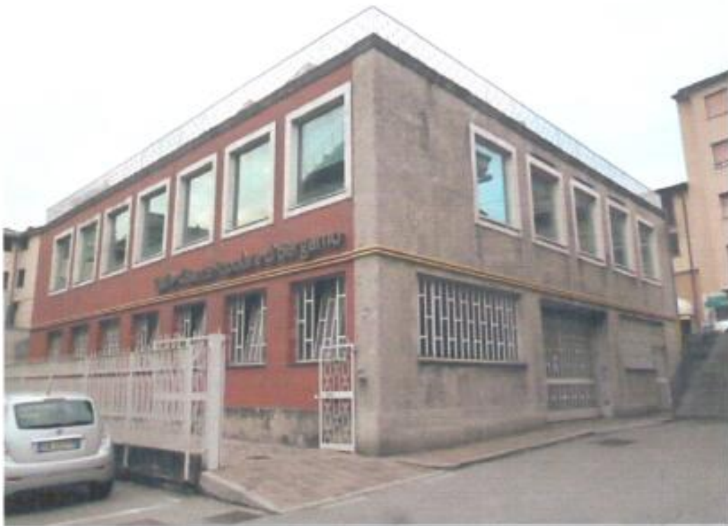
FOTO 1 – L'edificio di Via Marconi n° 14 in Gazzaniga, ingresso carroia/pedonale dalla strada
