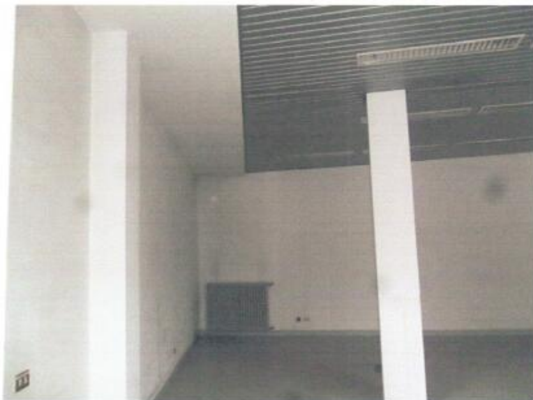
FOTO 8 – Particolare contrasoffittatura con elementi illuminanti incassati
