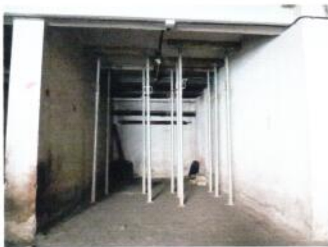
FOTO 8 – BOX Sub. 10, interno puntellato a sostegno sovrastante solaio caricato dai forzieri della banca
