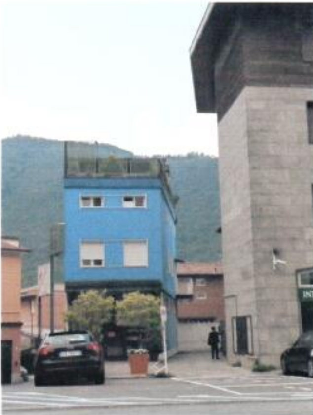
FOTO 2 – Al fianco dell'edificio via di accesso al BOX
