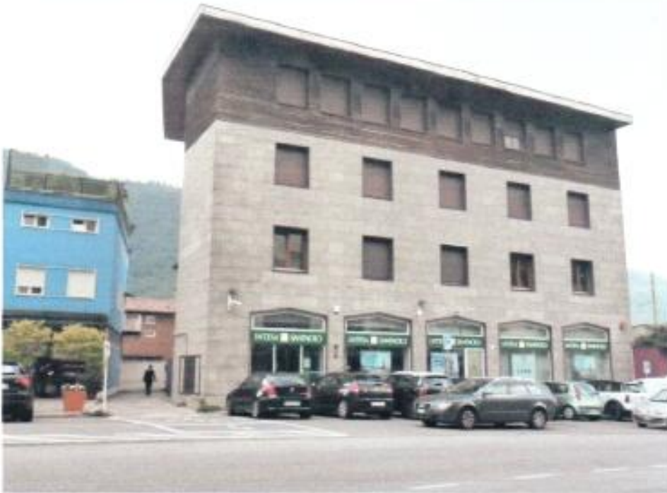
FOTO 1 – Immobile di Via Mansueilo n° 79 in Lumezzane
