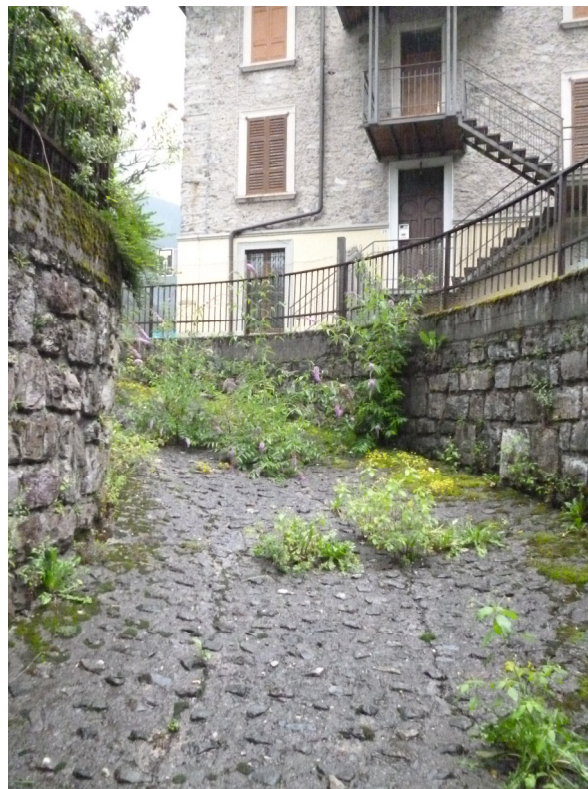
FOTO 2 – Rampa di ingresso carraio all'unità BOX sub. 11
