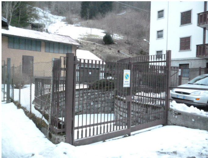
FOTO 10 – Cancello accesso rampa carraia unità BOX sub. 11
