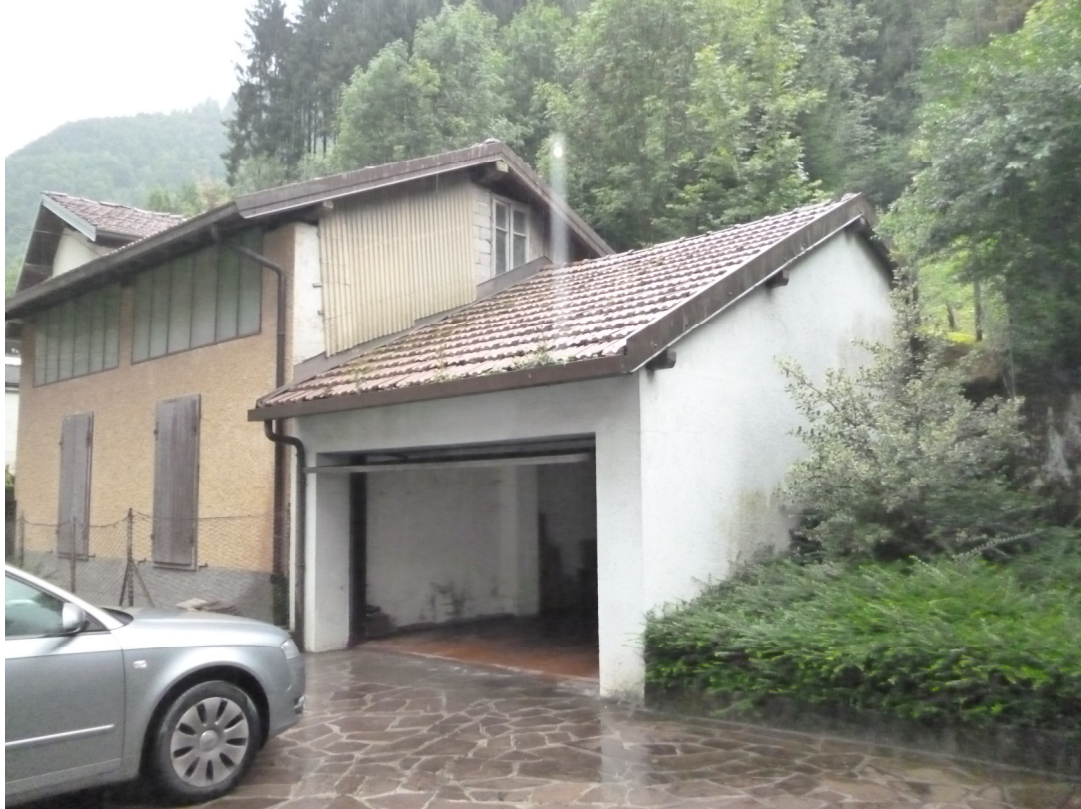
FOTO 7 – Area accesso e unità BOX sub. 12
