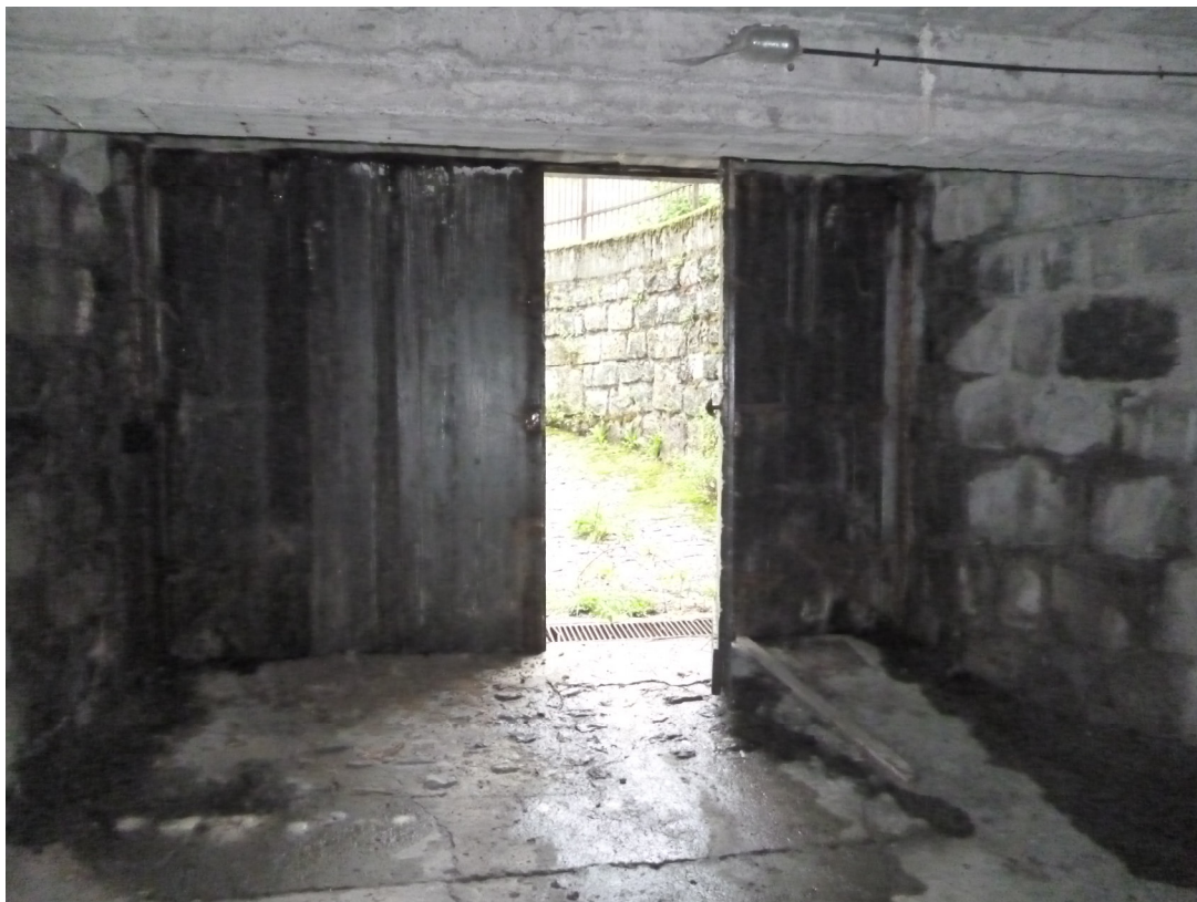
FOTO 4 – Area antistante BOX sub. 11, vista dall'area di manovra interna.
