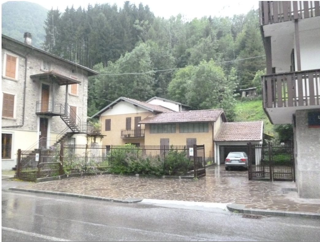
FOTO 1 – sito immobiliare di Via Papa Giovanni XXIII n° 31 in Colere, ingresso carraio/pedonale dalla strada
