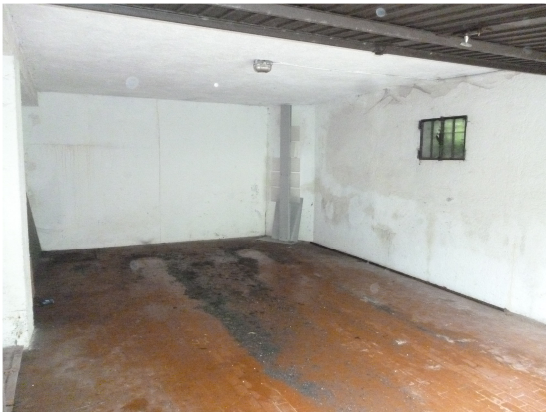
FOTO 8 – Particolare interno BOX sub. 12
