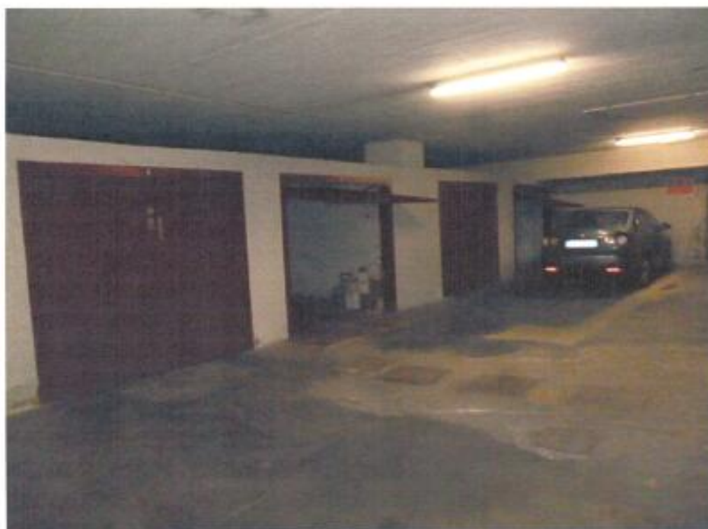
FOTO 4 – Corsello di accesso ai Sub 726, 728 e 729
