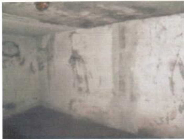
FOTO 5 e 6 - Box Sub 726 interno 1 e particolare di pareti e soffitto Sub. 726
