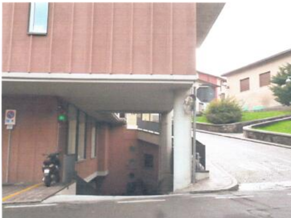
FOTO 2 – Accesso carralo alla rampa
