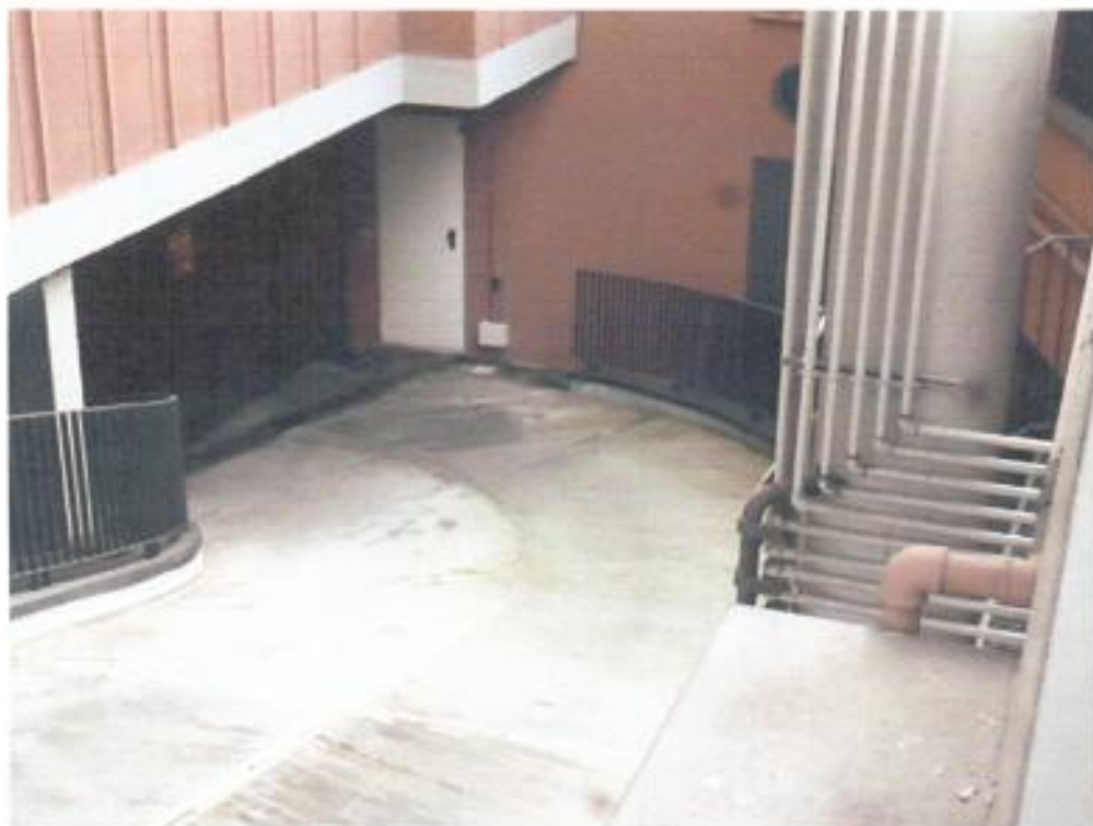
FOTO 3 – Accesso carrato alla rampa
