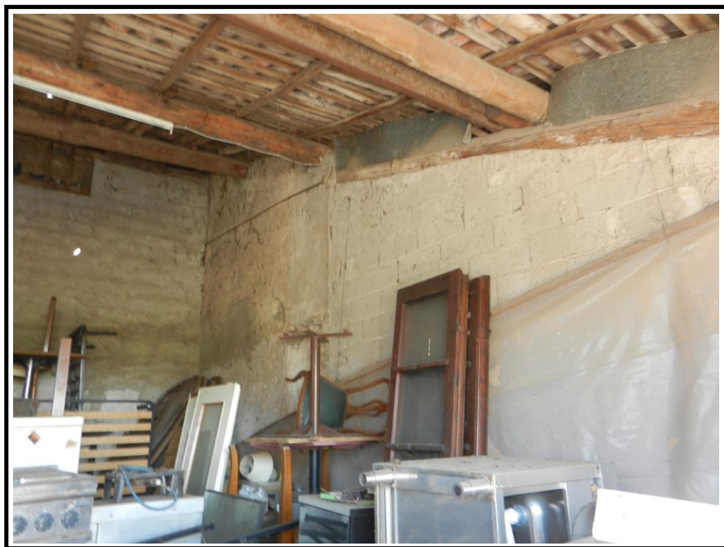
Foto 2 Vista interna autorimessa sub 6
