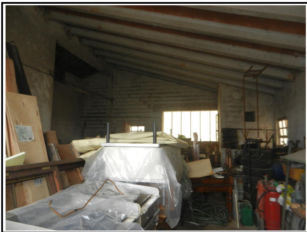
Foto 5 Vista interna sub 7
