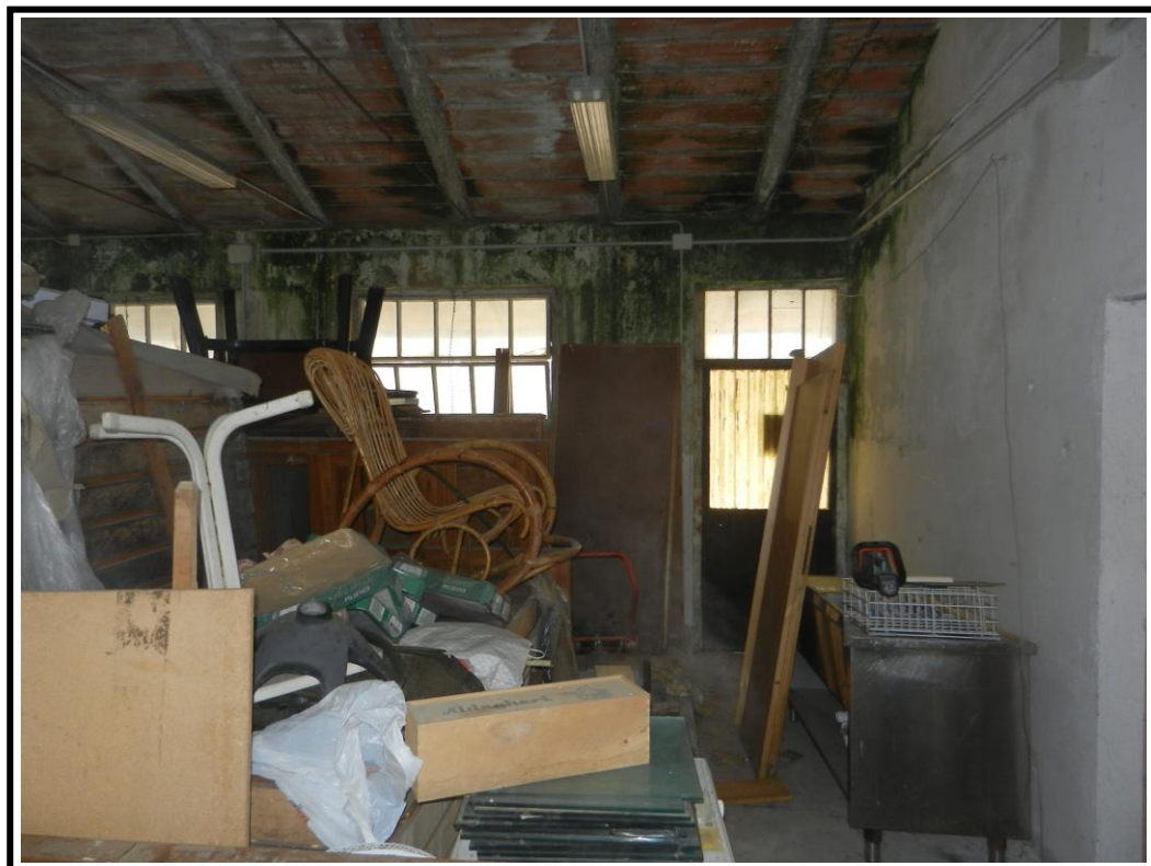
Foto 6 Vista interna sub 7
