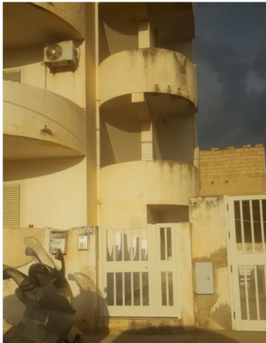
Cancello d'ingresso e scala esterna
