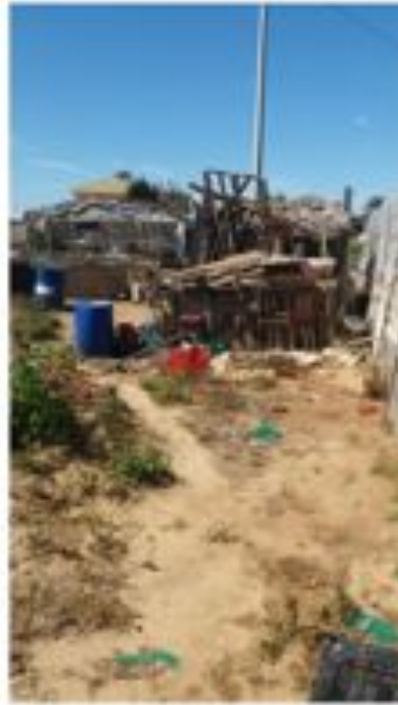
strutture precarie in zona pozzo
