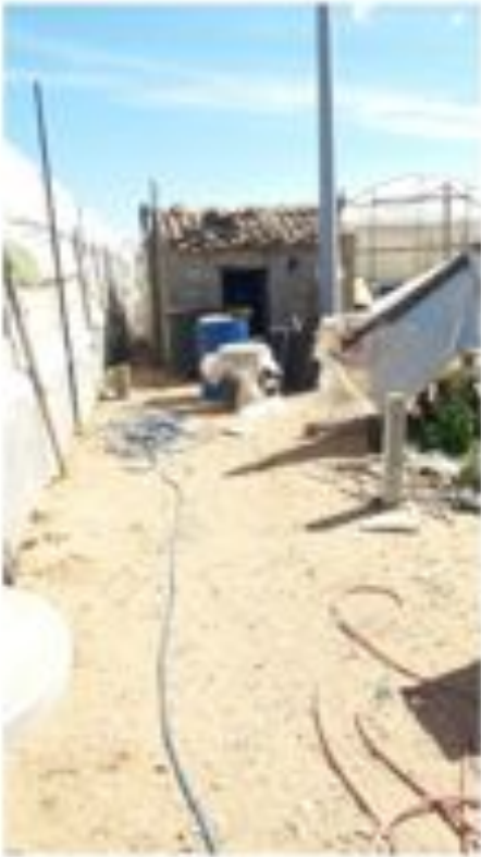
fabbricato rurale adibito a locale pozzo
