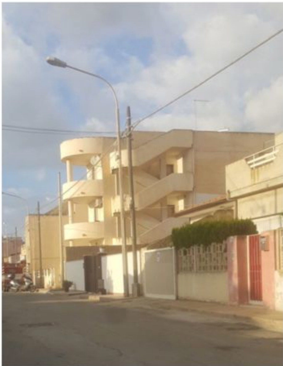
Palazzina lato Sud-Est
