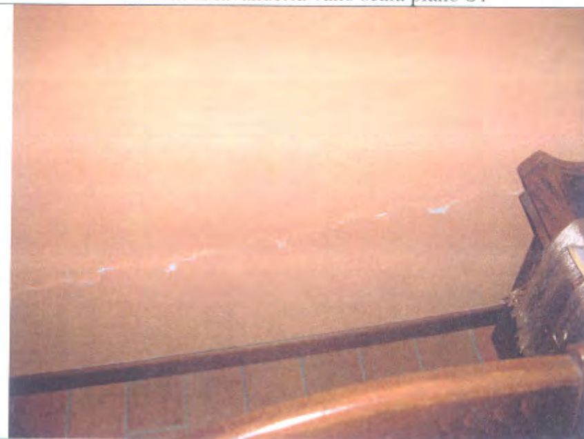
Villetta A traccia umidità intonaco per allagamento piano terreno
