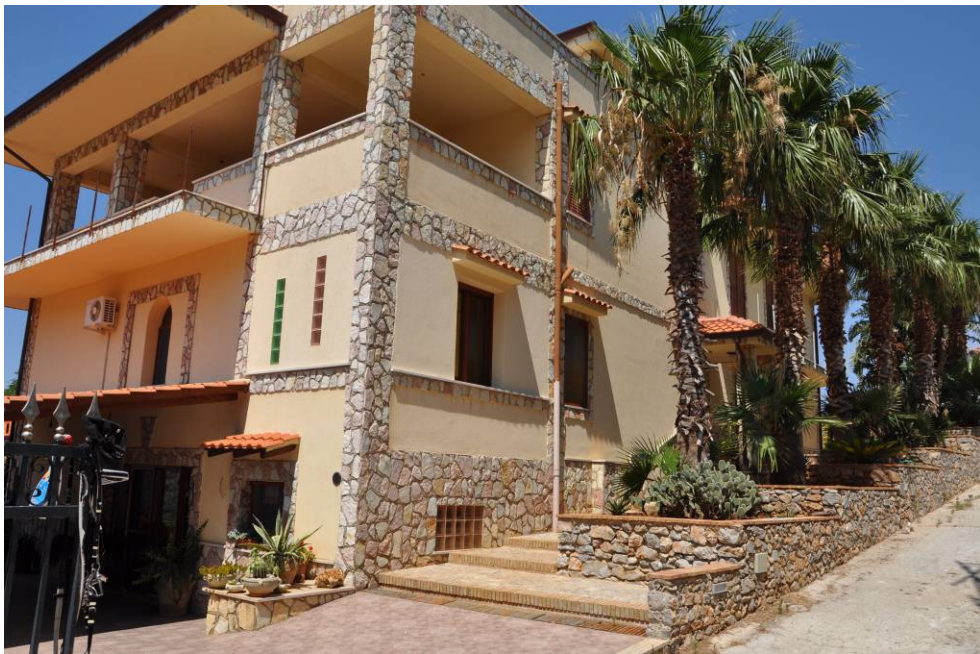
Figura 2 : Veduta della villa dalla corte
