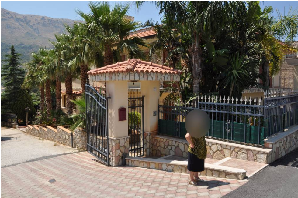
Figura 1 : ingresso alla villa
