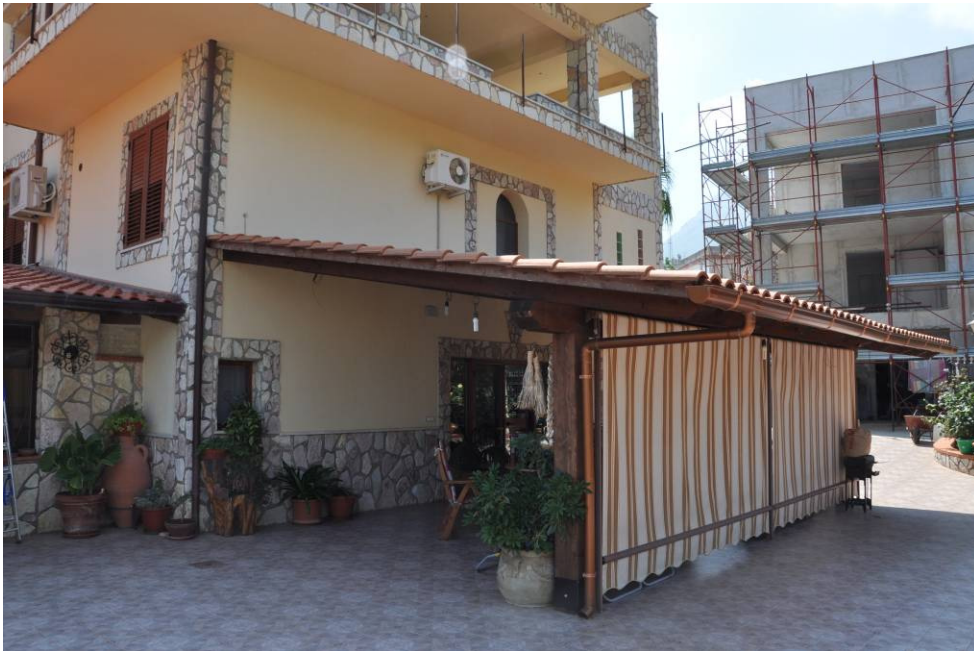
Figura 3 : veduta della villa dalla corte
