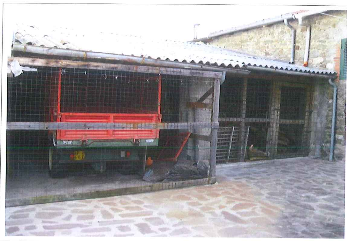
Foto n. 5 - Immobile di cui al cespite C) – Porticato da demolire
