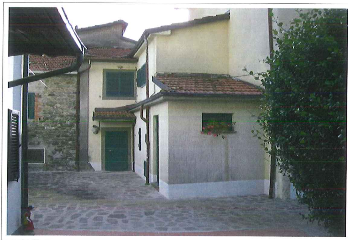
Foto n. 2 – Immobile di cui al cespite A) – Lato nord e porzione ovest
