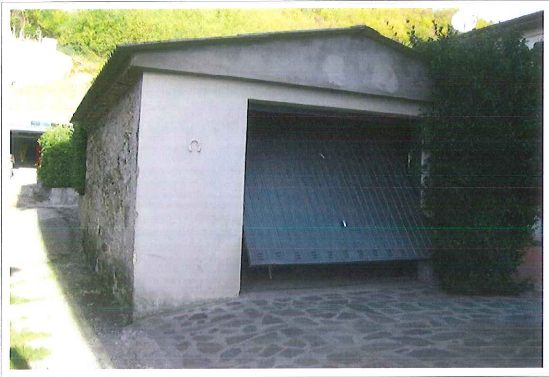
Foto n. 3 - Immobile di cui al cespite B) - Lato est e nord
