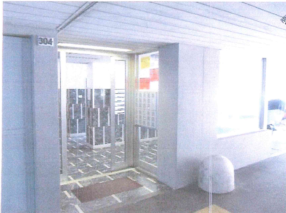
Ingresso del caseggiato tramite porticato coperto
