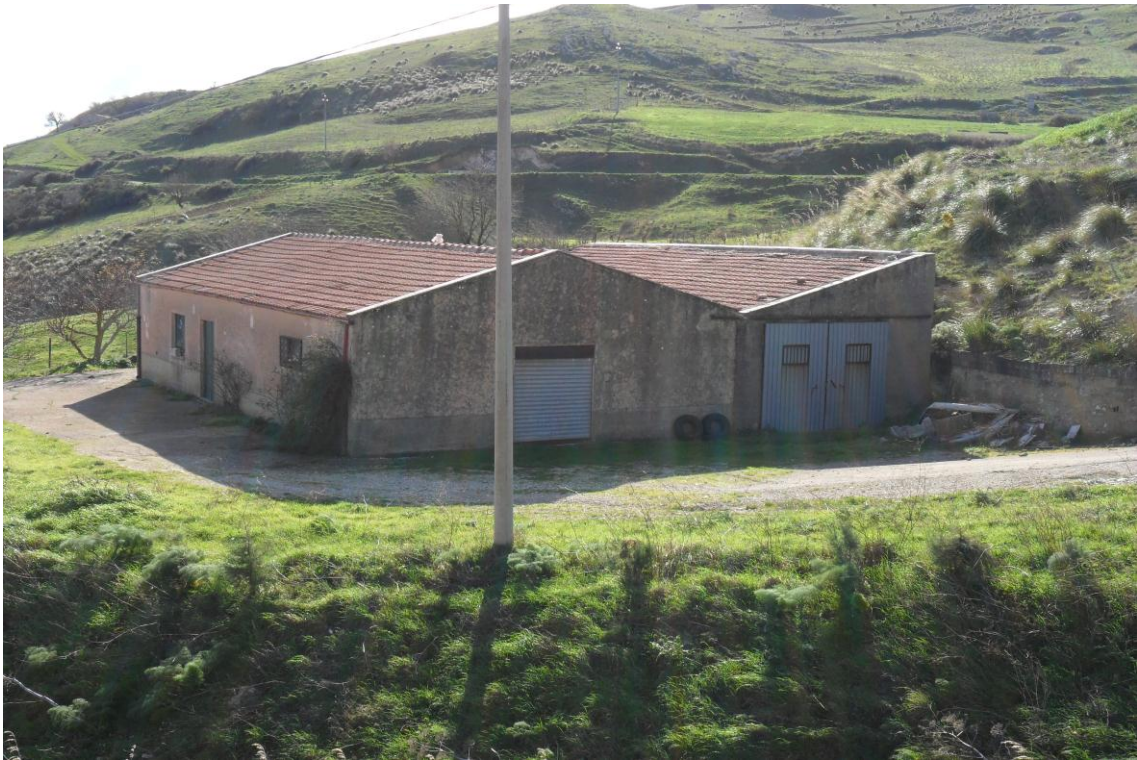
Foto 9 – Fabbricato in contrada Kassar (foglio 28 p.lla 665-667
