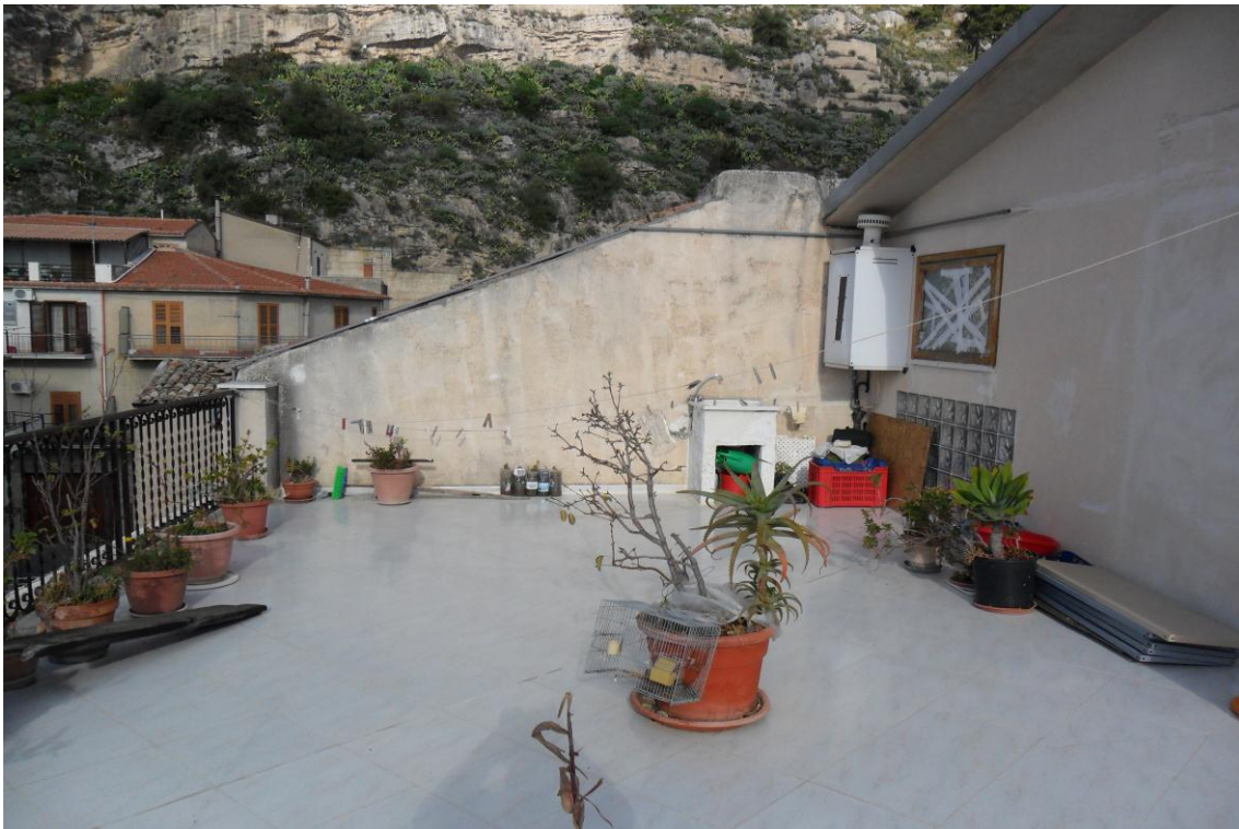
Foto 7 – Terrazzo a piano terzo (foglio MU p.Ila 735 sub. 11)
