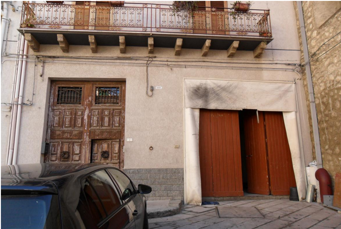
Foto 2 – Ingresso del fabbricato sito in Piazza San Giovanni n. 2
