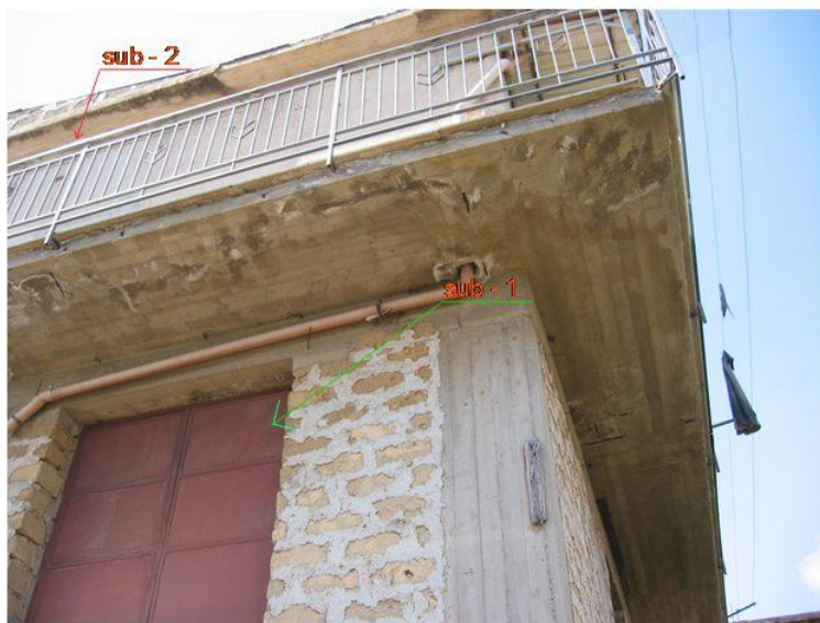
DEGRADO BALCONI
