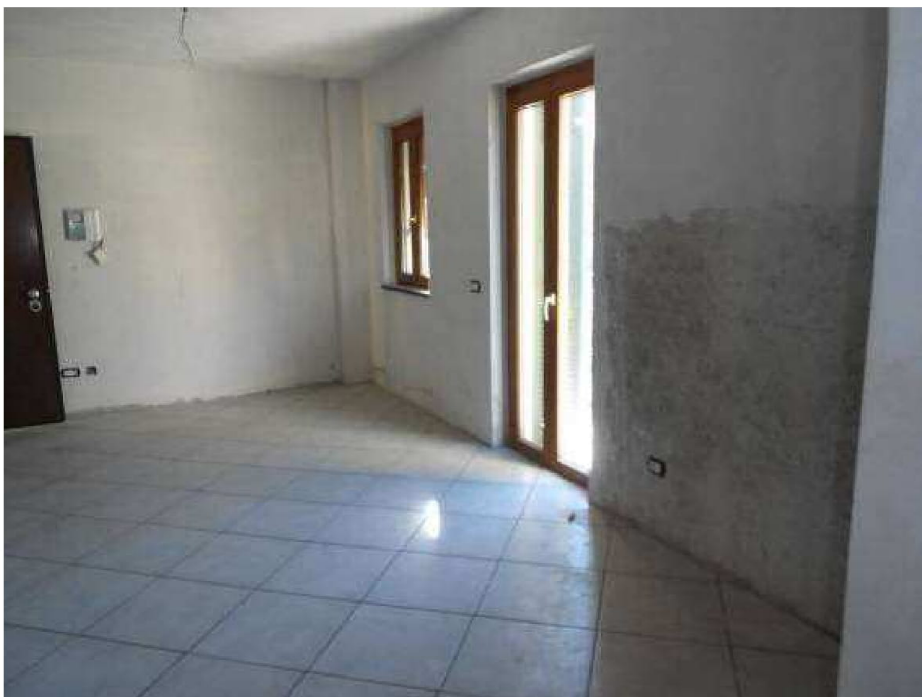
FOTO N°51 Lotto 4 Borzonasca (GE), Via Augusto Raggio 18/4
