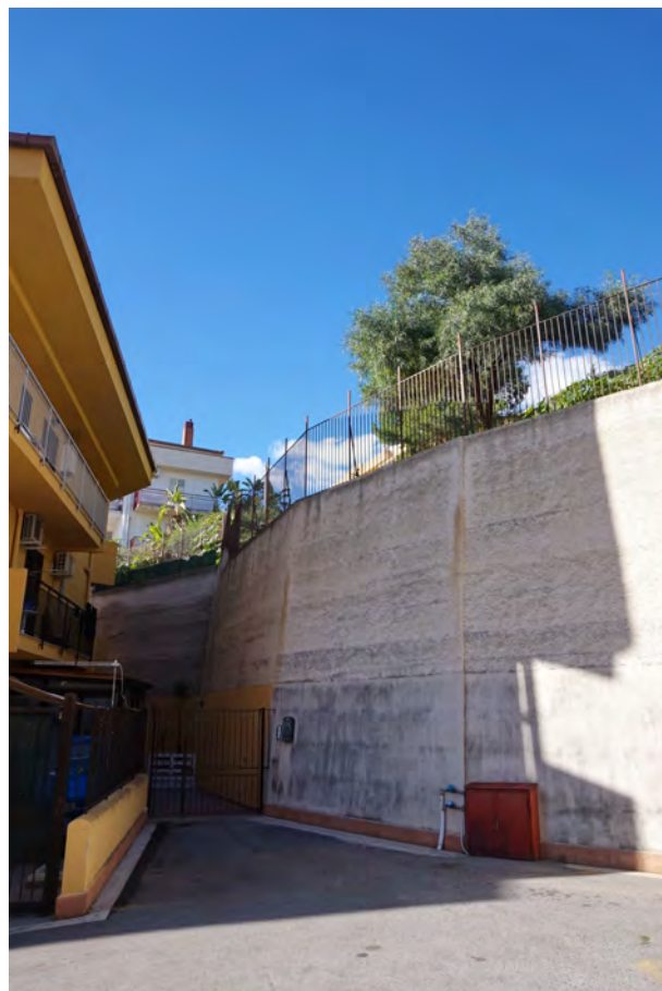
foto 41 - vista dell'area condominiale dal basso
