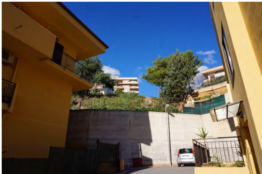
foto 37 - foto del muro di contenimento del terreno
