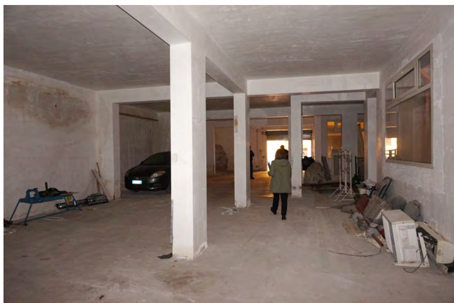
foto 32 - vista ambiente interno
