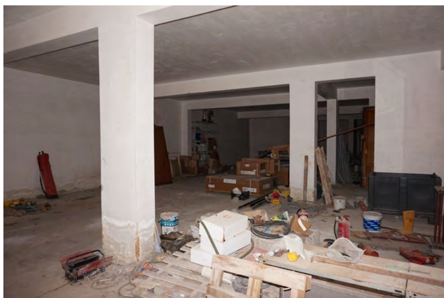
foto 30 - vista ambiente interno
