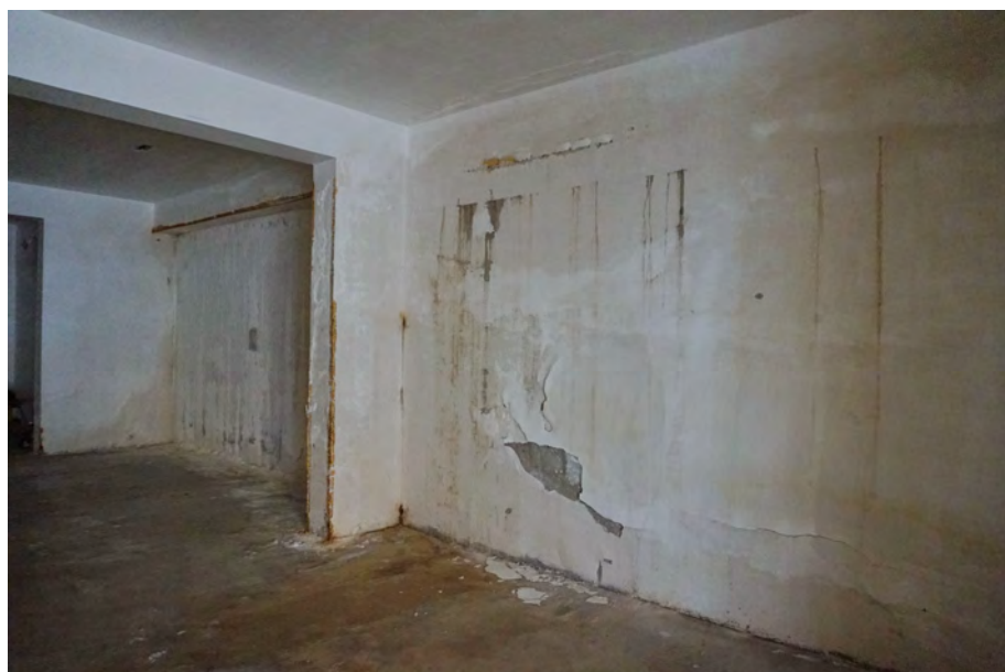
foto 33 - vista muro lato est a confine con il terrapieno
