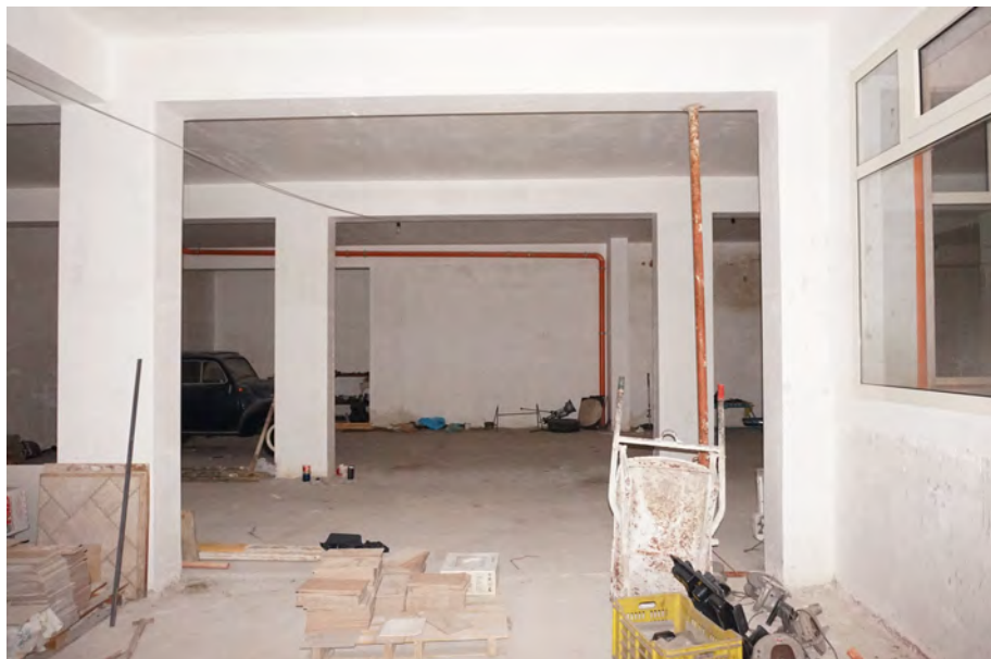
foto 31 - vista ambiente interno
