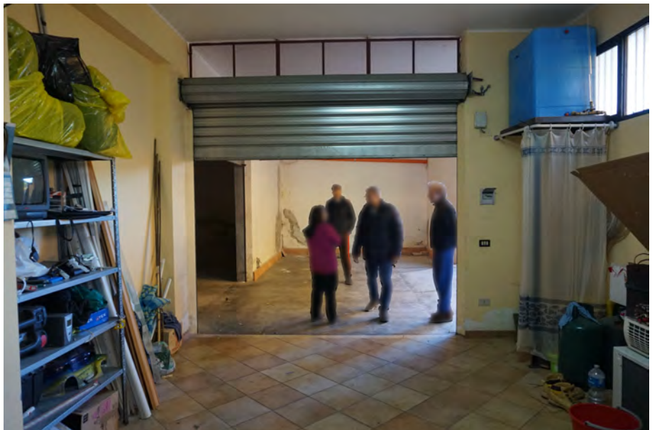
foto 23 - vista della porzione di magazzino resa indipendente
