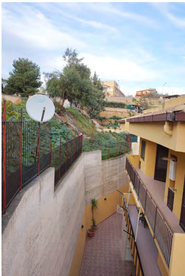
foto 40 - vista dell'area condominiale dall'alto
