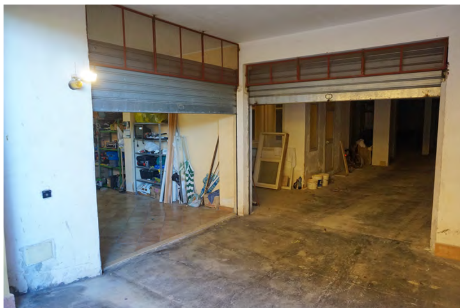
foto 21 - Ingressi Est al magazzino del piano S2
