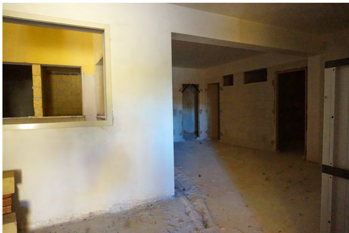
foto 9 - ingresso dal area condominiale esterna
