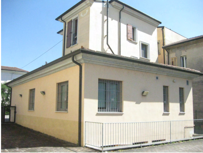
Foto n° 5: vista del complesso dal cortile
