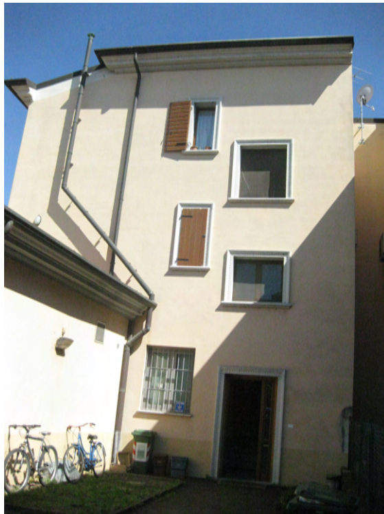
Foto n° 6: vista del portoncino d'ingresso del complesso
