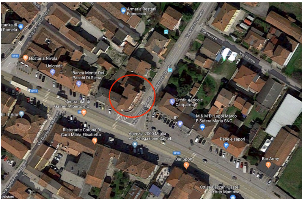
Foto n° 1: vista aerofotogrammetrica dell'edificio
