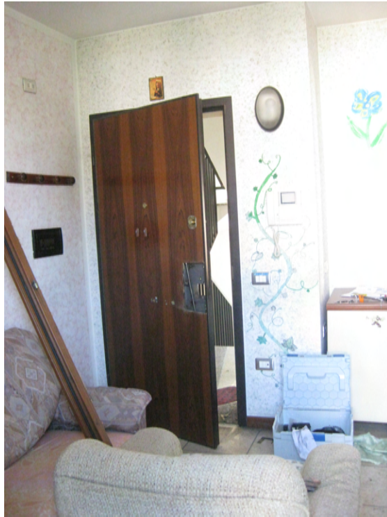
Foto n° 9: vista porta d'ingresso dell'interno
