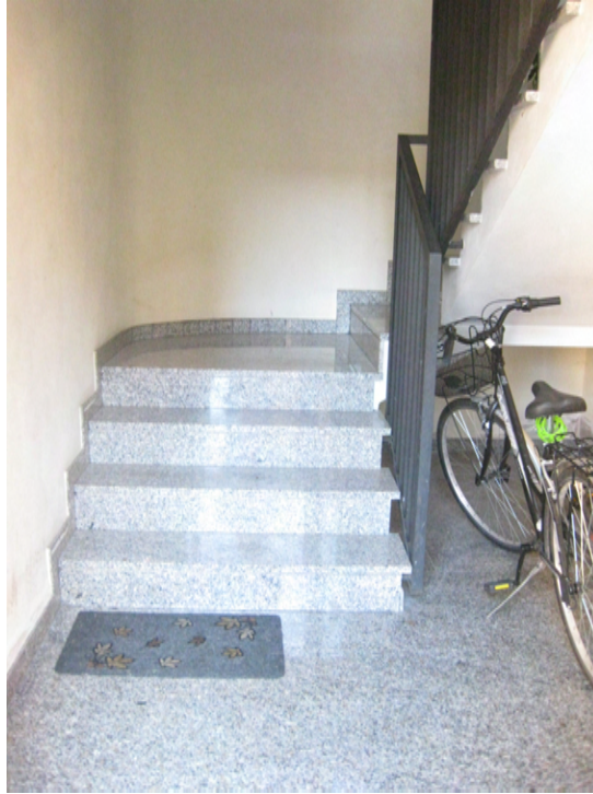
Foto n° 7: vista del vano scala
