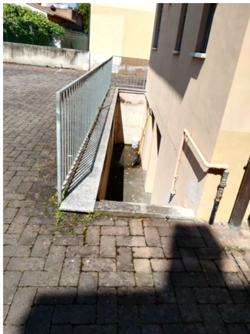
Foto n° 16: vista scala per piano interrato
