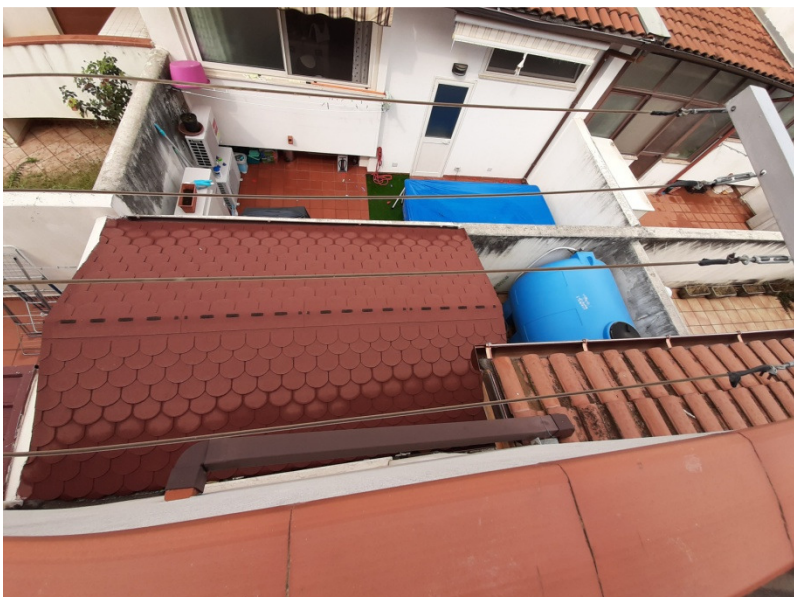
Corte retrostante vista dall'alto con tettoia abusiva sopra il w.c. in legno e copertura in tegole sopra la scala di accesso al p.interrato
