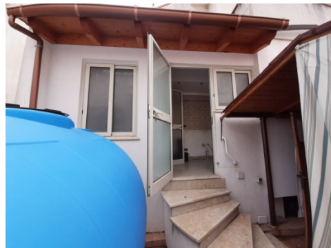
Originario balcone cucina oggi chiuso - zona cucina realizzata chiudendo abusivamente porzione della corte esterna sul retro
