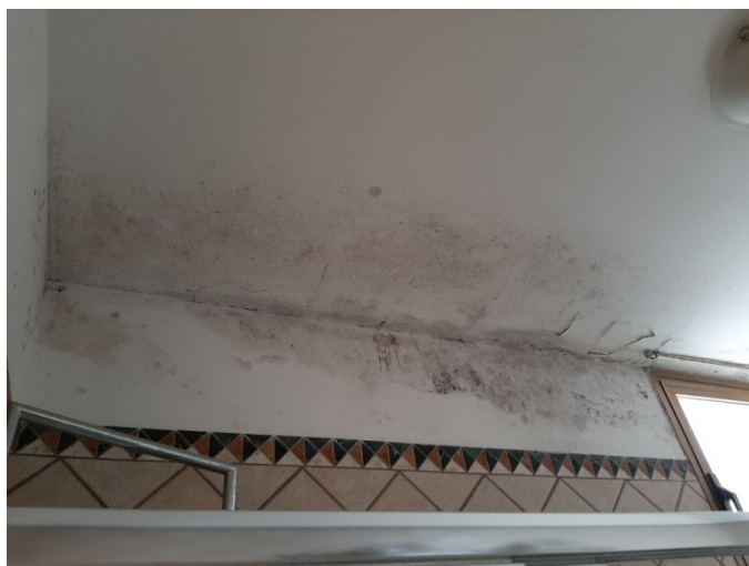
Presenza di umidità proveniente dalla copertura
