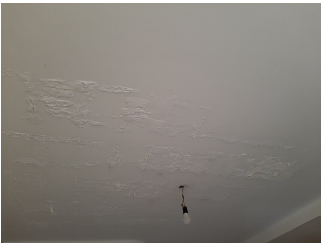
Presenza di umidità nel solaio di piano rialzato
