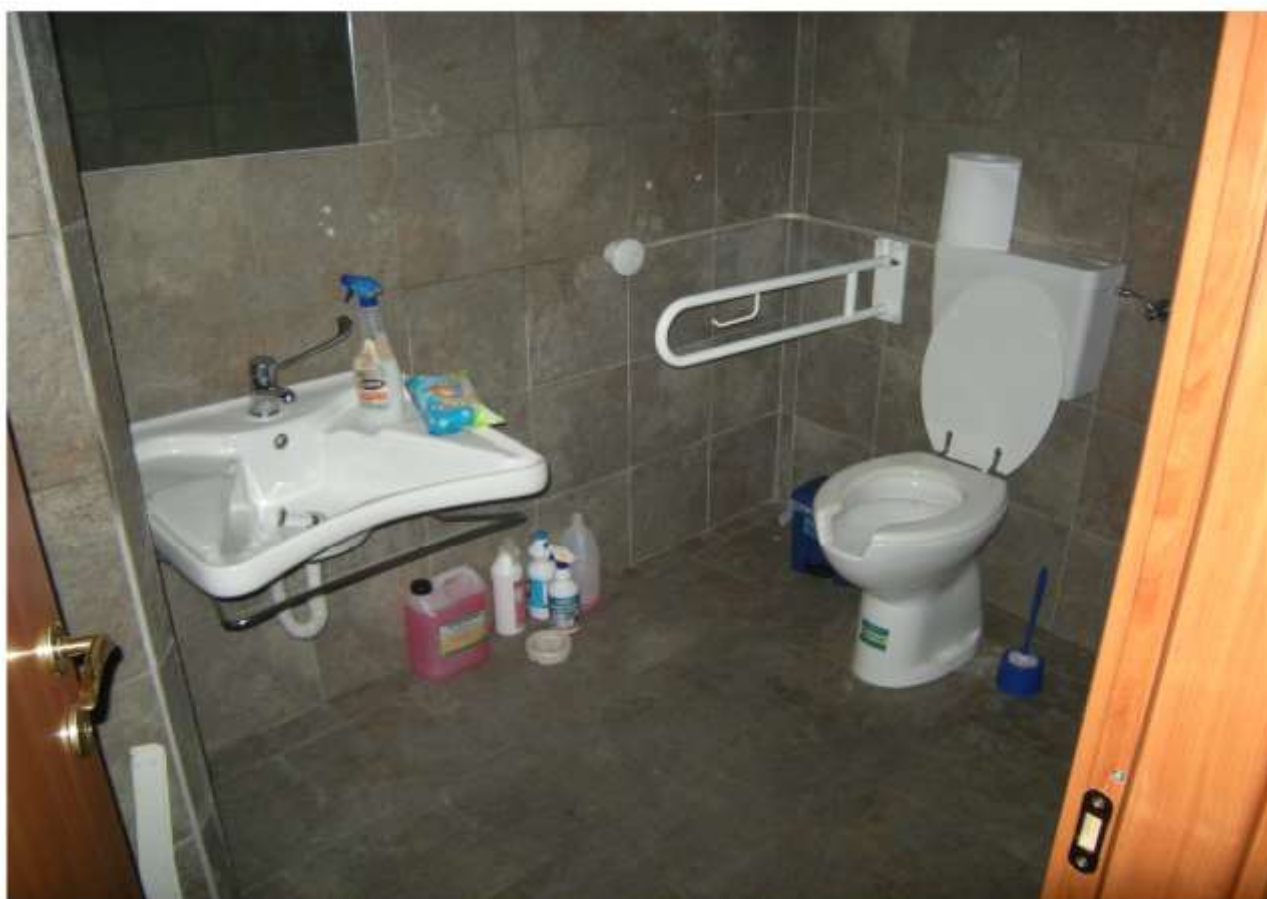
Foto 09 – Interno servizi piano terra
