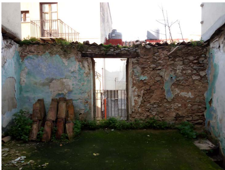
Foto n. 7 – Vano primo piano e privo di solaio di copertura
