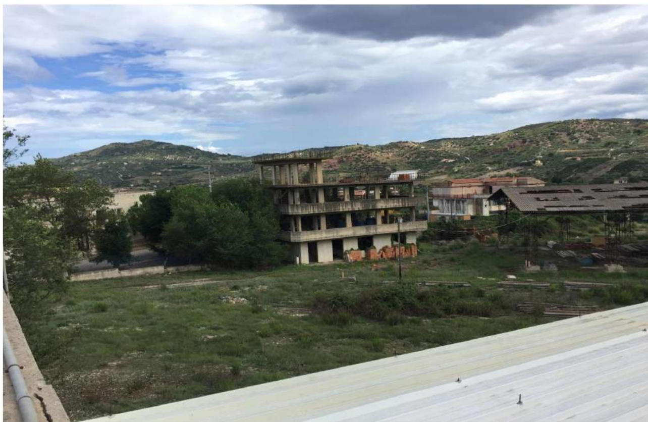
Veduta del bene dal tetto del manufatto abusivo mq. 420,00
