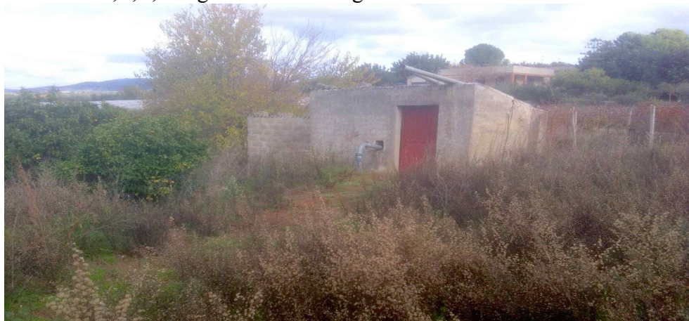
Foto 10 Lotti 2, 3, 4, 5. Fabbricato al Foglio 26 Chiaramonte C.da Serra Berretta
