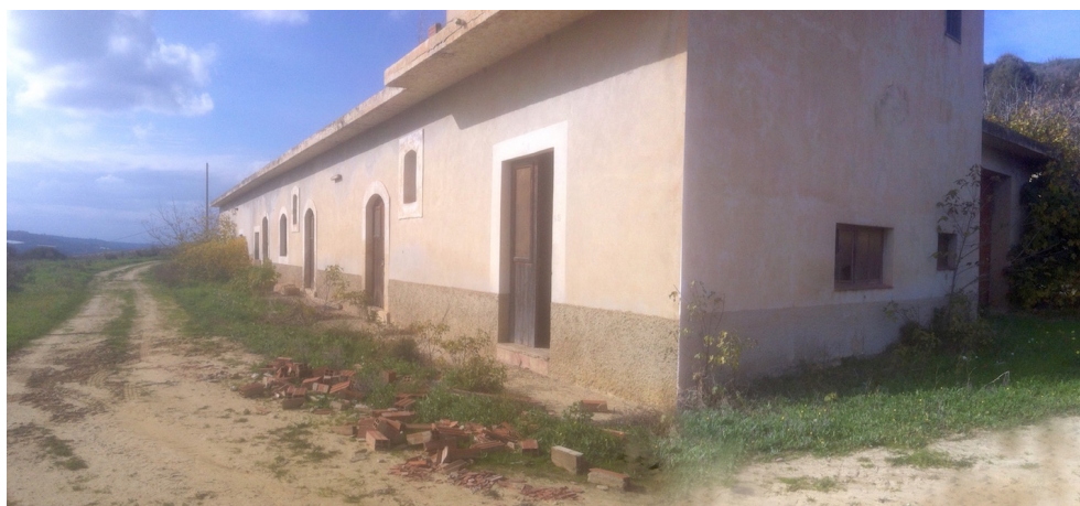
Foto 5 Lotto 1. Fabbricato e deposito. Foglio 5 Acate Contrada Bidini
