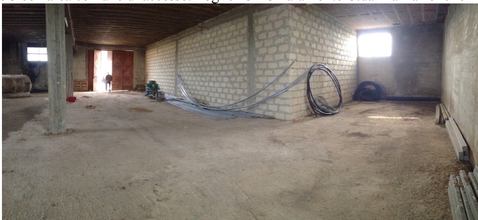
Foto 28 Lotto 5. Interno Deposito particella 592 sub 2. Foglio 132 Chiaramonte Gulfi Contrada Mazzarronello
