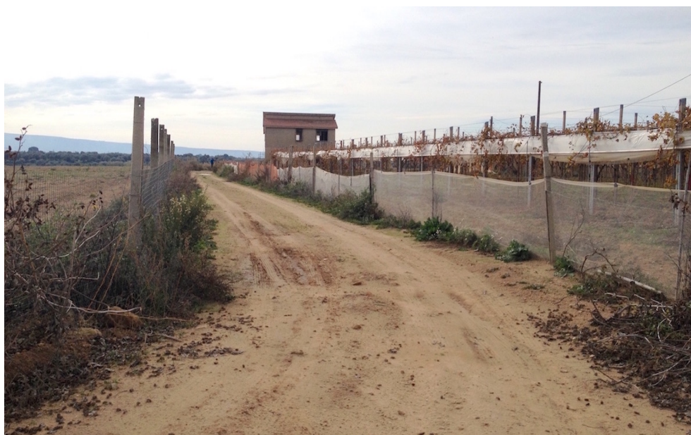
Foto 16 Lotti 2, 3, 4, 5. Strada interna comune di accesso al fabbricato al deposito e invaso tra le particelle 454 e 453. Foglio 132 Chiaramonte Gulfi Contrada Mazzarronello
