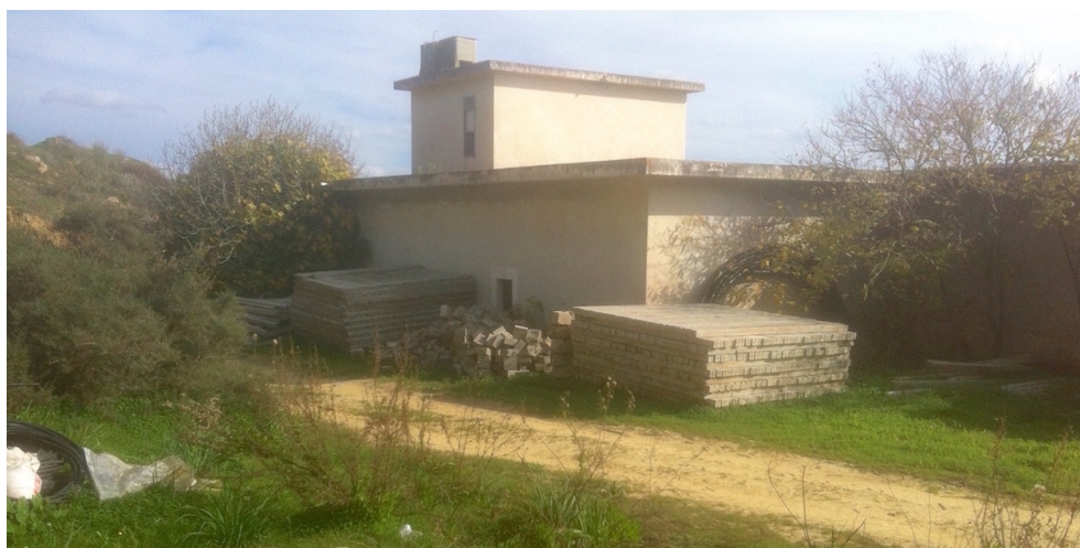
Foto 6 Lotto 1. Fabbricato e deposito. Foglio 5 Acate Contrada Bidini
