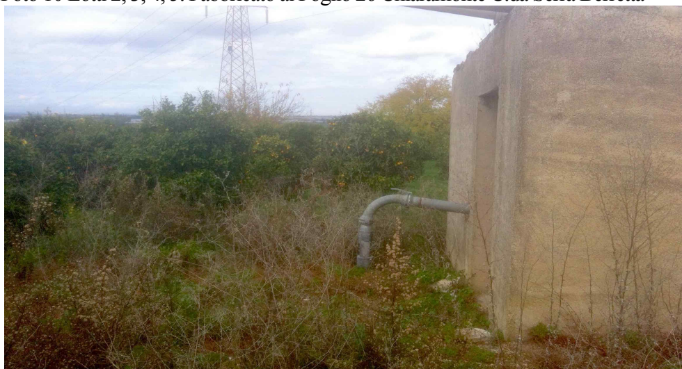
Foto 11 Lotti 2, 3, 4, 5. Fabbricato e pozzo. Foglio 26 Chiaramonte C.da Serra Berretta
