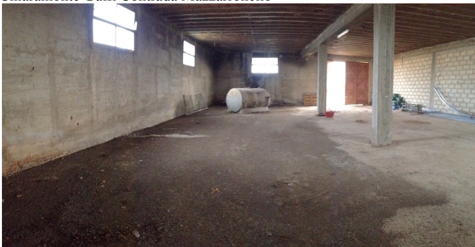
Foto 29 Lotto 5. Interno Deposito particella 592 sub 3. Foglio 132 Chiaramonte C.da Mazzarronello
