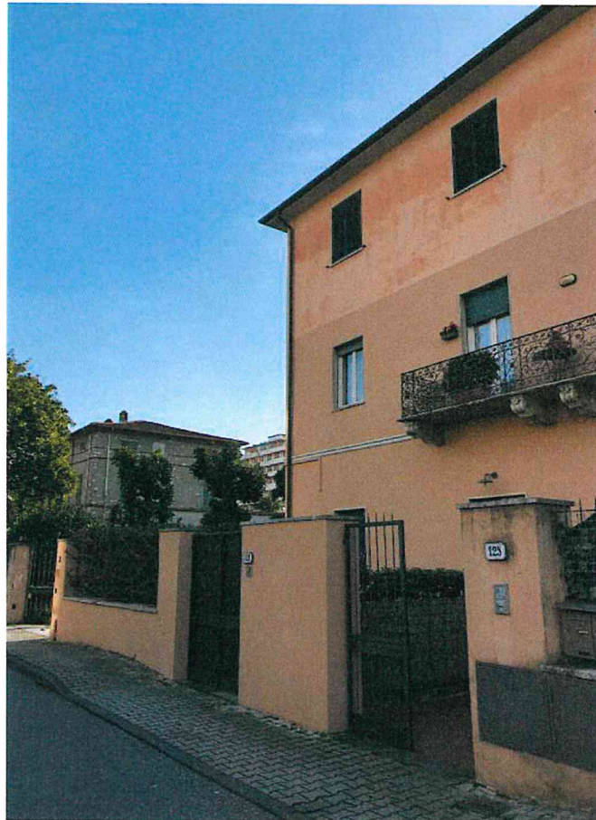
Prospetto principale latovia Mancini.
