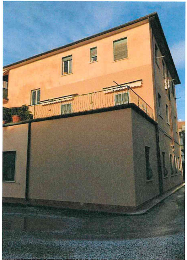
Esterno fabbricato.lato retro.
