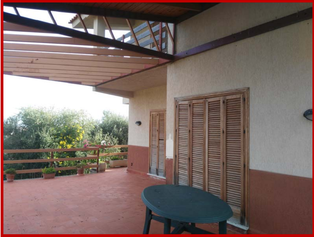
20. Piano terra Portico
