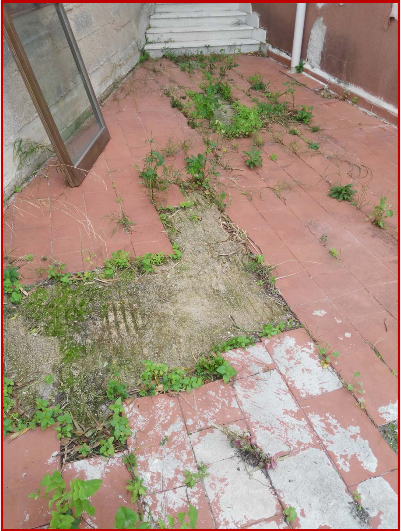
23. Pavimenti esterni lato sud
