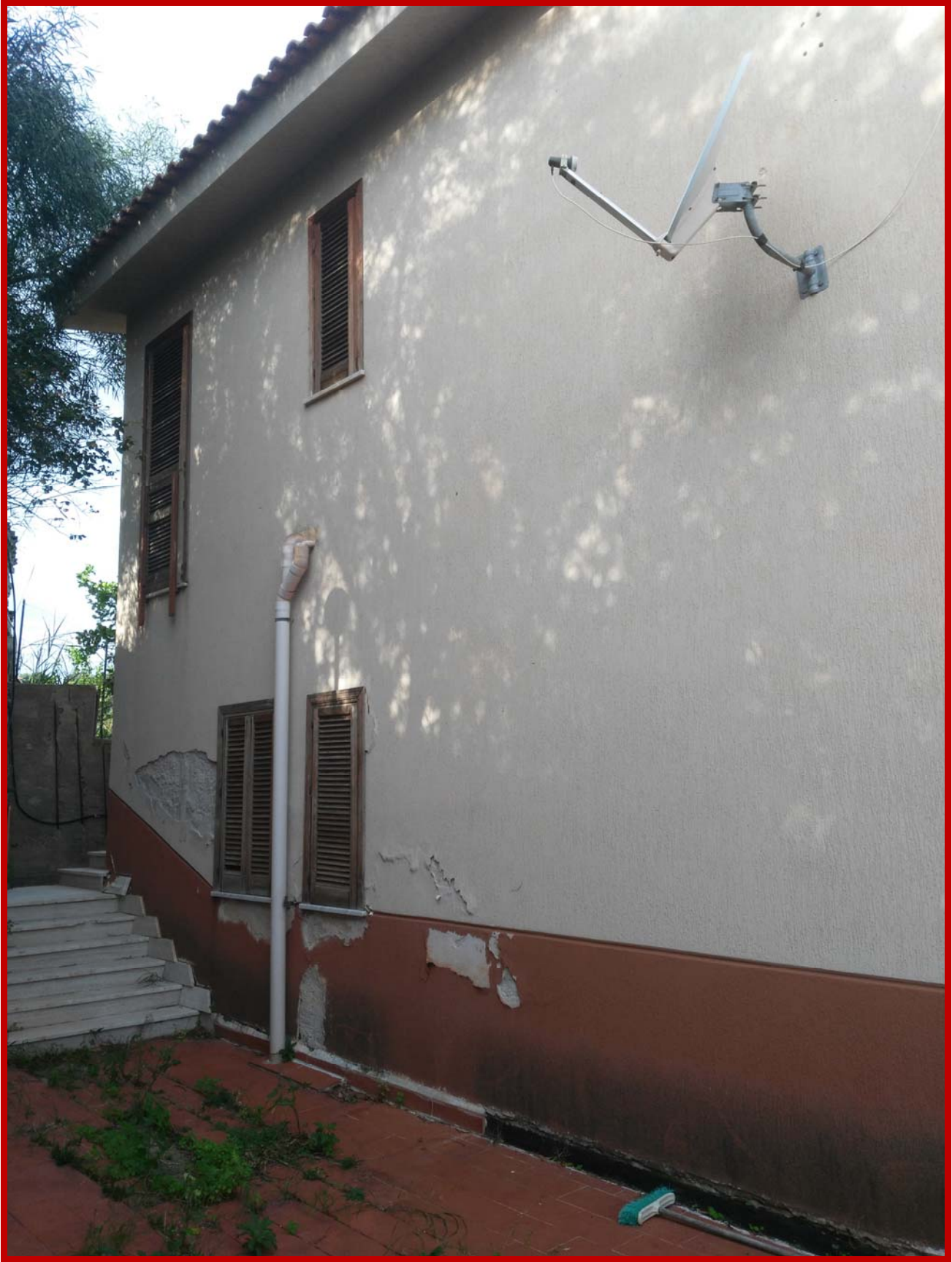
22. Vista lato sud
