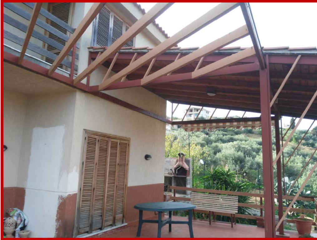
18. Piano terra Portico
