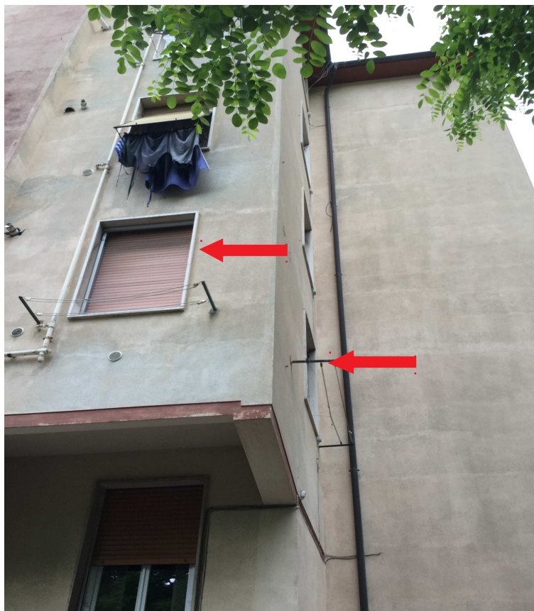
Foto n. 17- Edificio civ. 26- prospetto Est. In evidenza finestre soggiorno/cucina .
