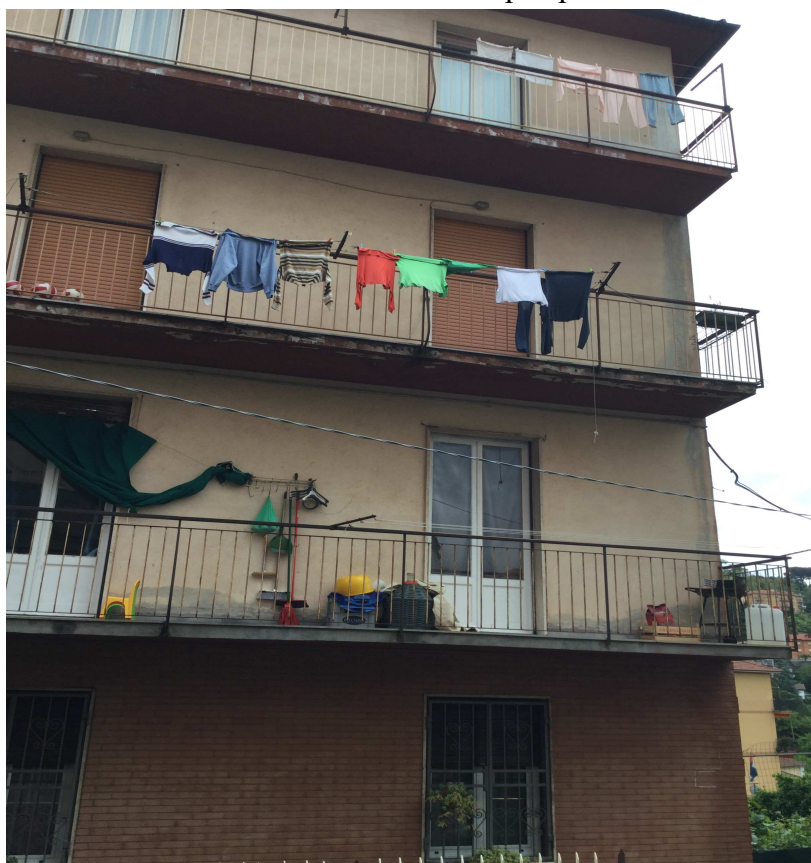
Foto n. 11- Edificio civ. 26- prospetto ovest
