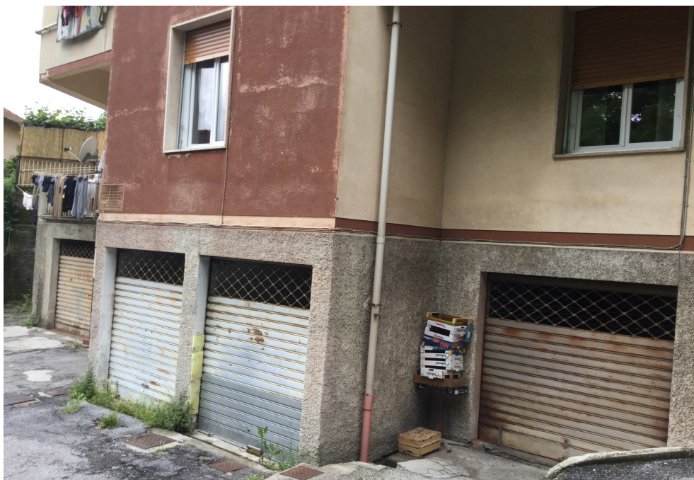
Foto n. 15- Piano terra lato est edificio.
