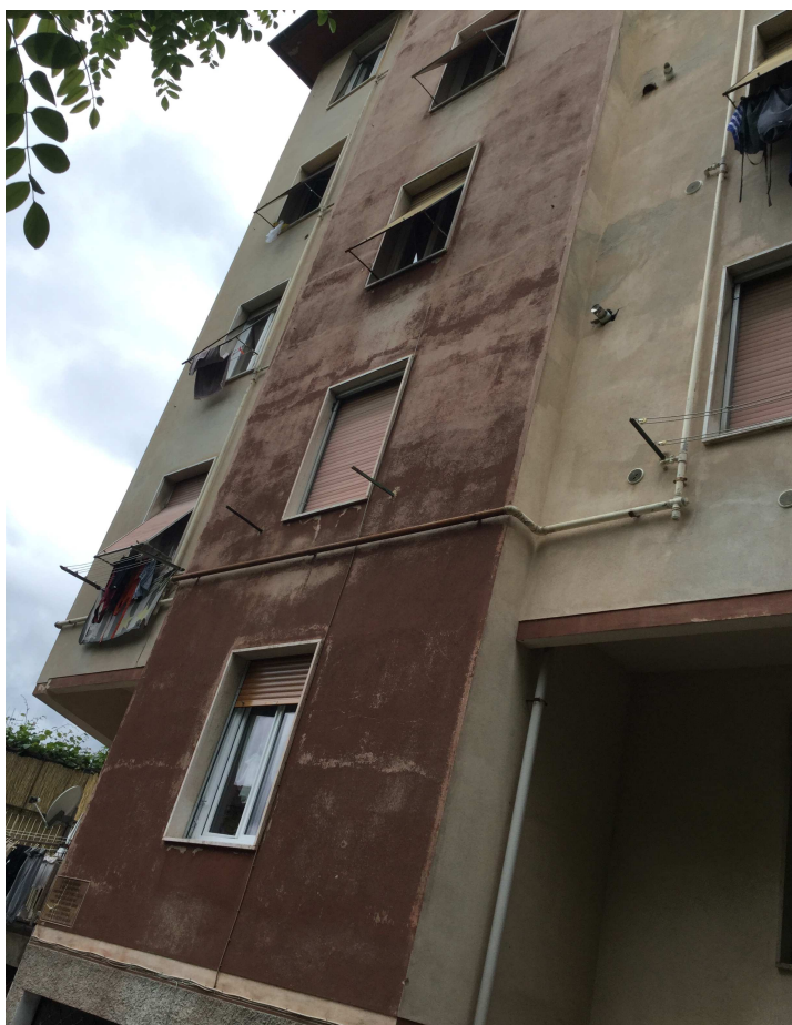
Foto n. 14- Edificio civ. 26- prospetto Est
