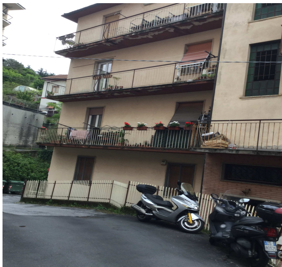
Foto n. 9- Edificio civ. 26-prospetto ovest
