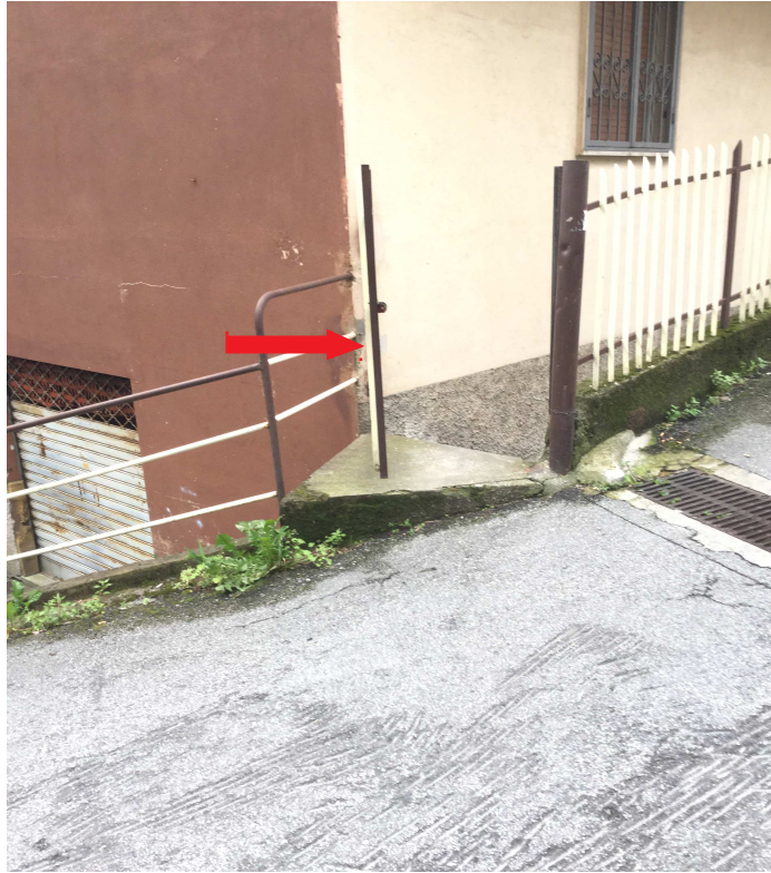
Foto n. 19- Altro percorso di accesso alla cantina
