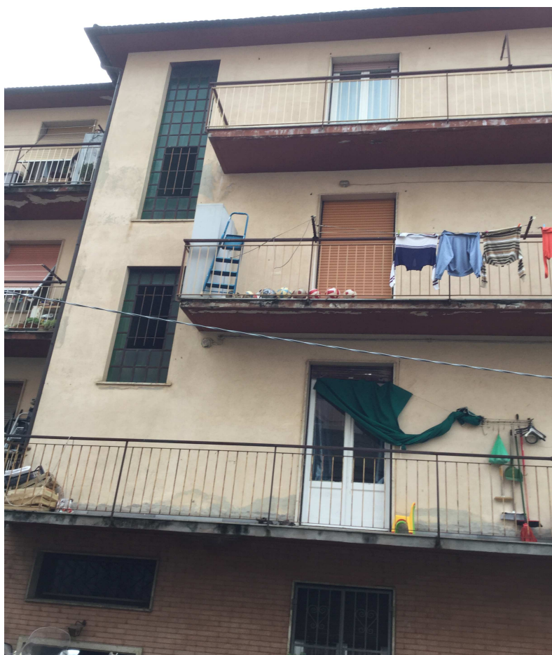
Foto n. 10- Edificio civ. 26- prospetto ovest
