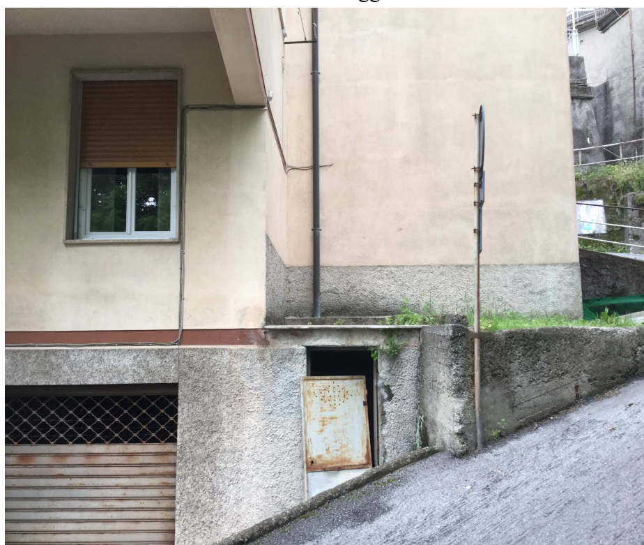
Foto n. 18- Edificio civ. 26- prospetto Est. Visibile la pendenza della strada.
