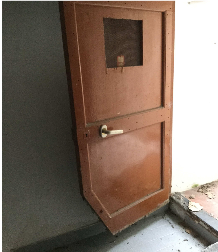
Foto n. 21- Porta di accesso cantina
