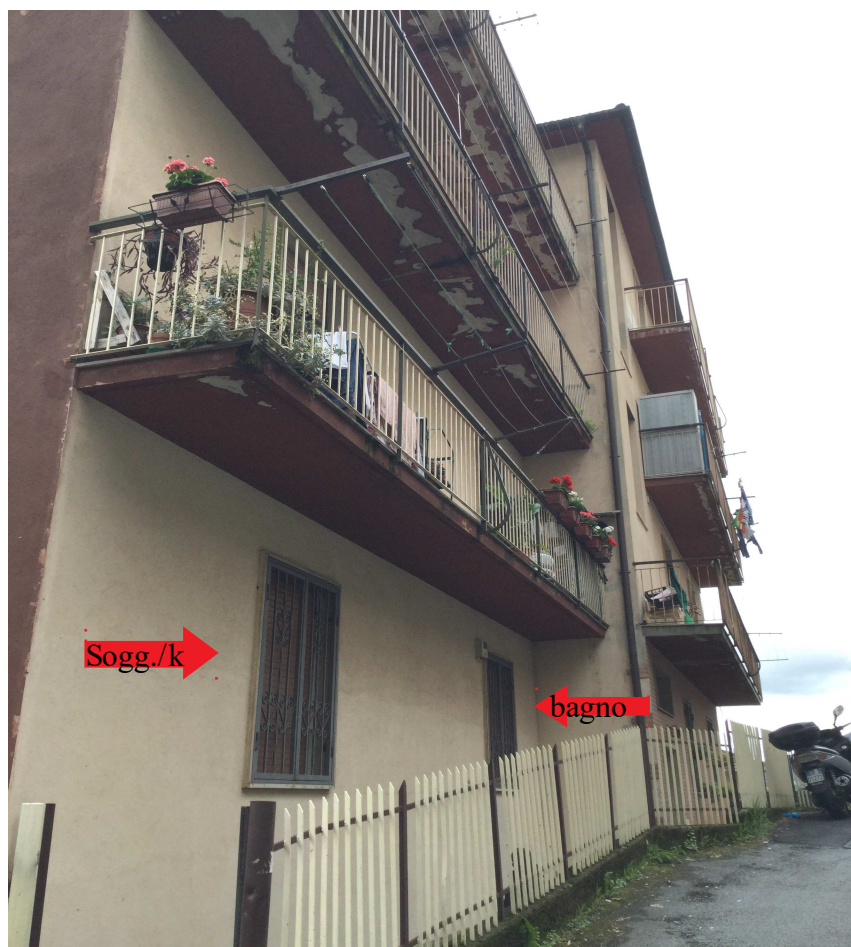
Foto n. 5- In evidenza le finestre del soggiorno/cucina e del bagno appartamento civ. 26 interno n. 1
