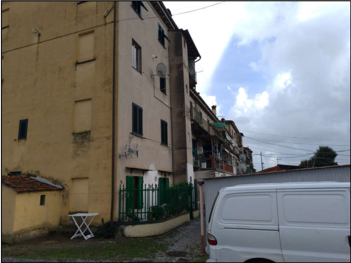
Foto 3 – Vista del prospetto sud-ovest del fabbricato
