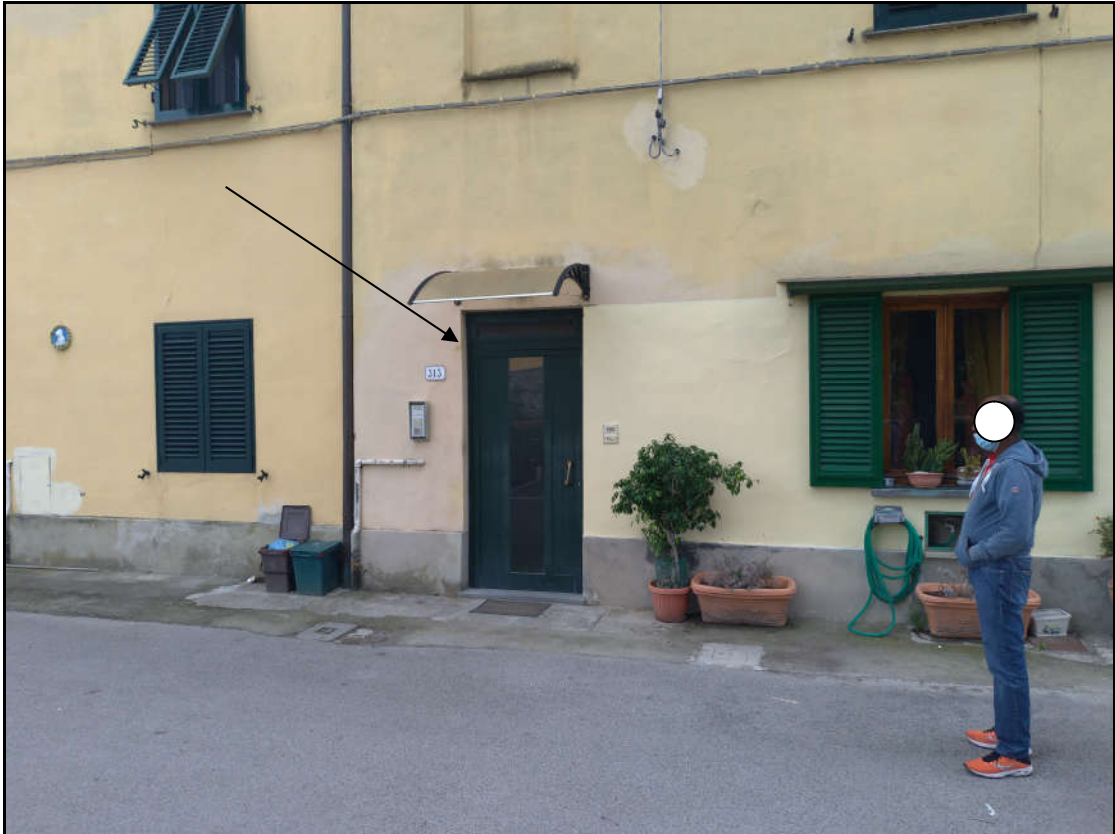
Foto 4 – Ingresso all'androne e vano scala condominiali dal resede del fabbricato
