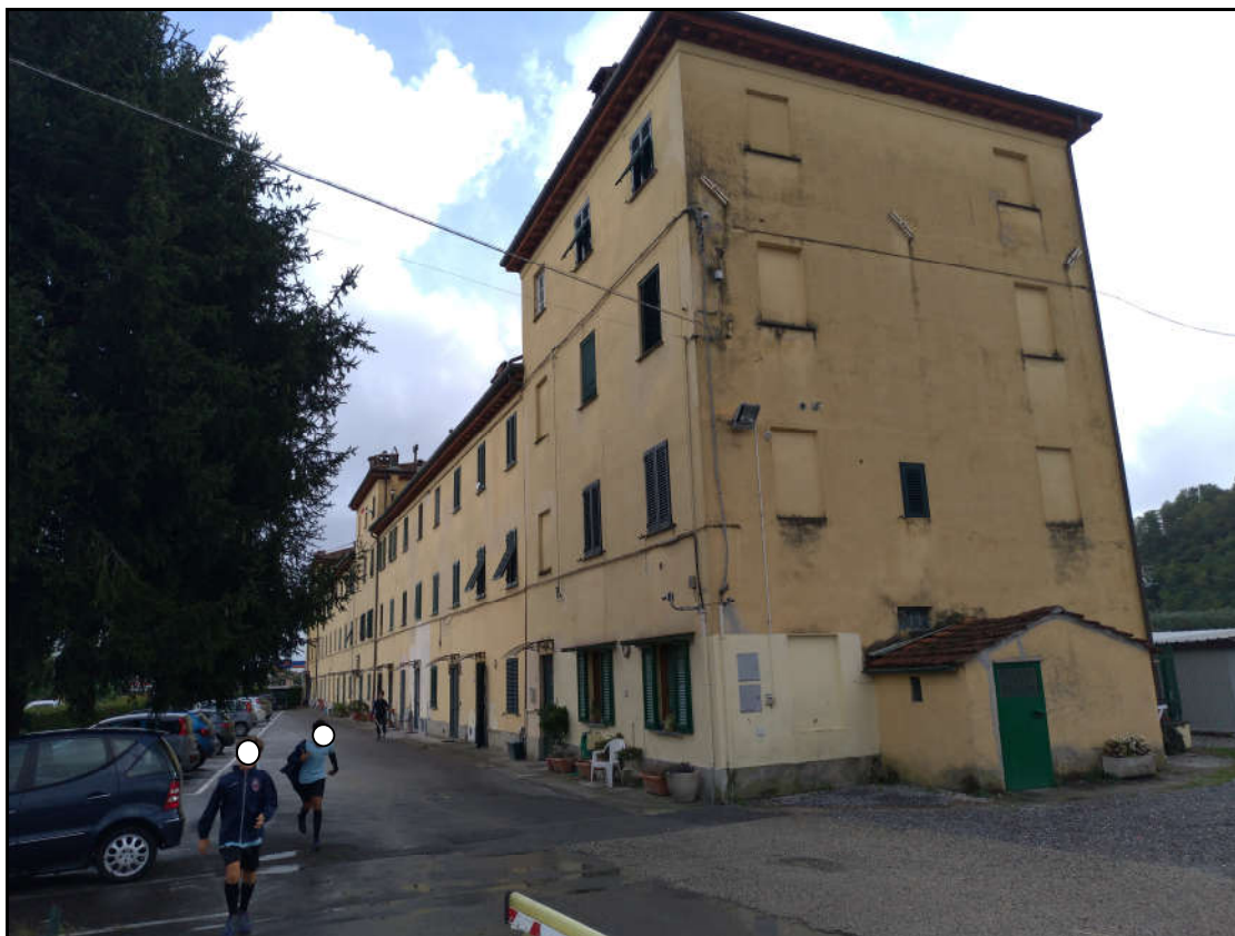
Foto 1 – Vista d'insieme dei prospetti nord-est e nord-ovest del fabbricato
