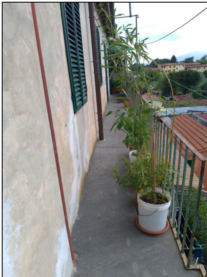
Foto 9 – Vista del ballatoio condominiale al secondo piano
