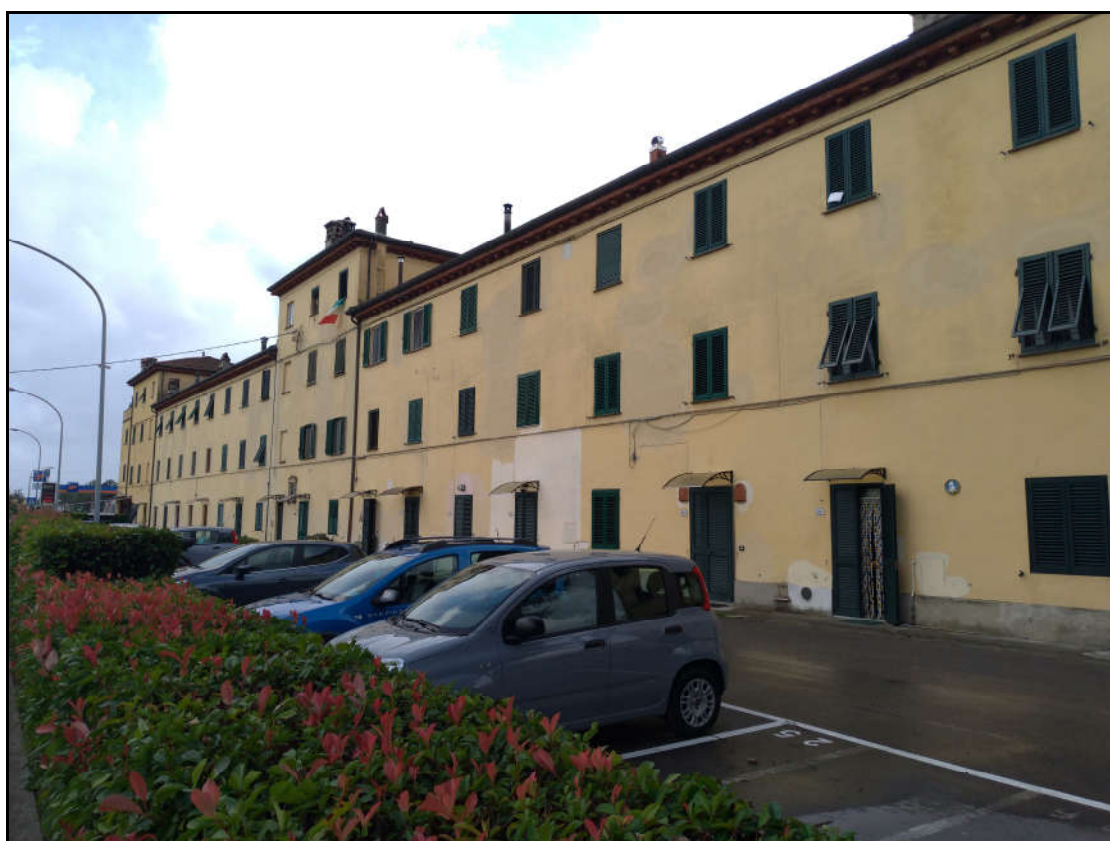
Foto 2 – Vista del prospetto nord-est di affaccio sulla via Nazionale
