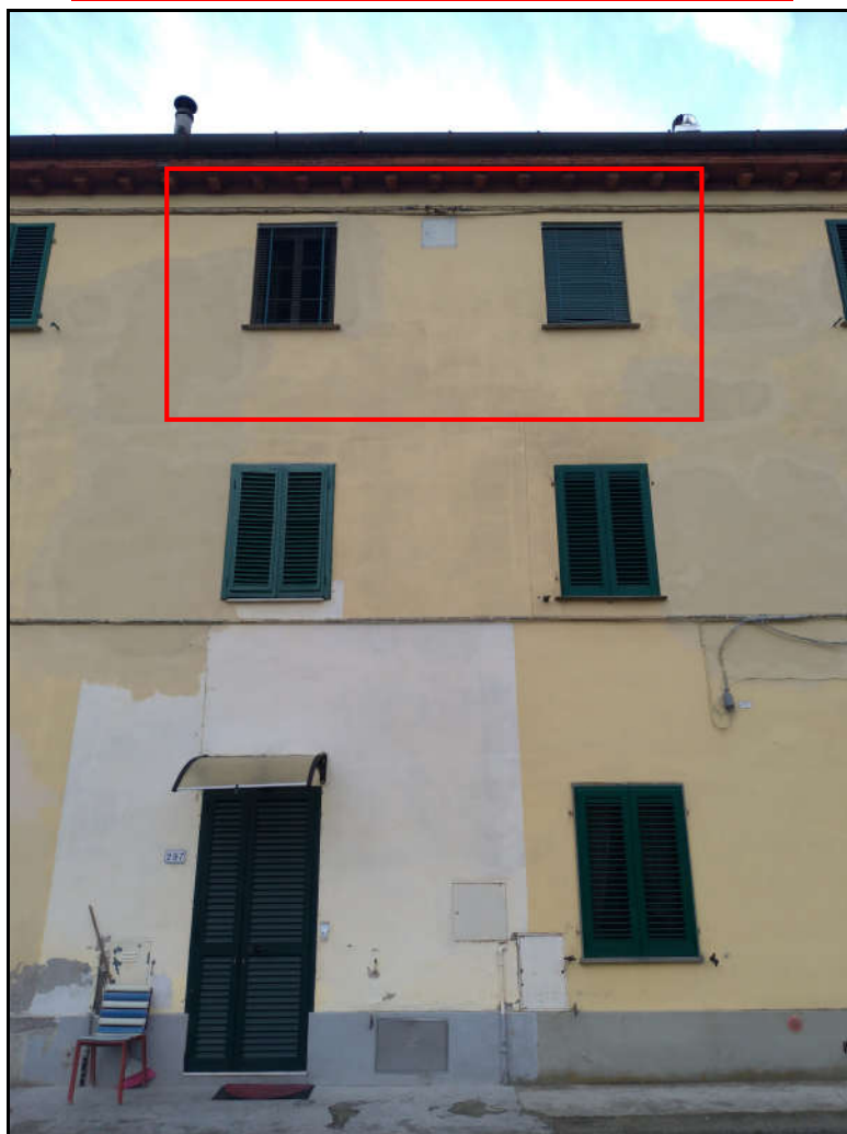
Foto 5 – Porzione del prospetto nord-est di affaccio dell'unità immobiliare al secondo piano
