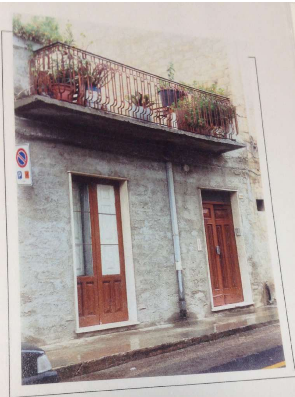
Foto n. 4: Prospetto su via Duca D'Aosta
