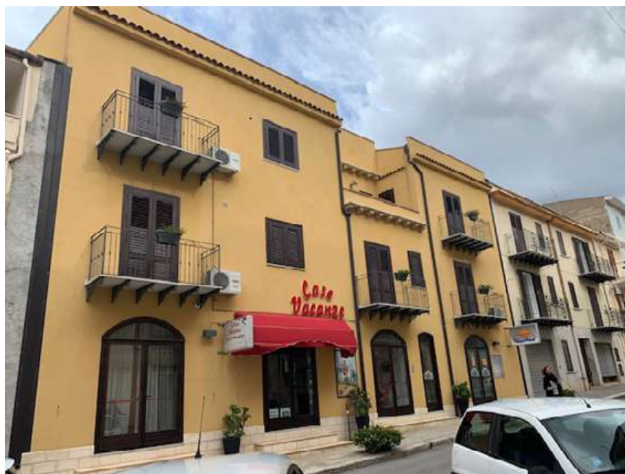
Foto 1. Prospetto dell'intero fabbricato su via Roma.
