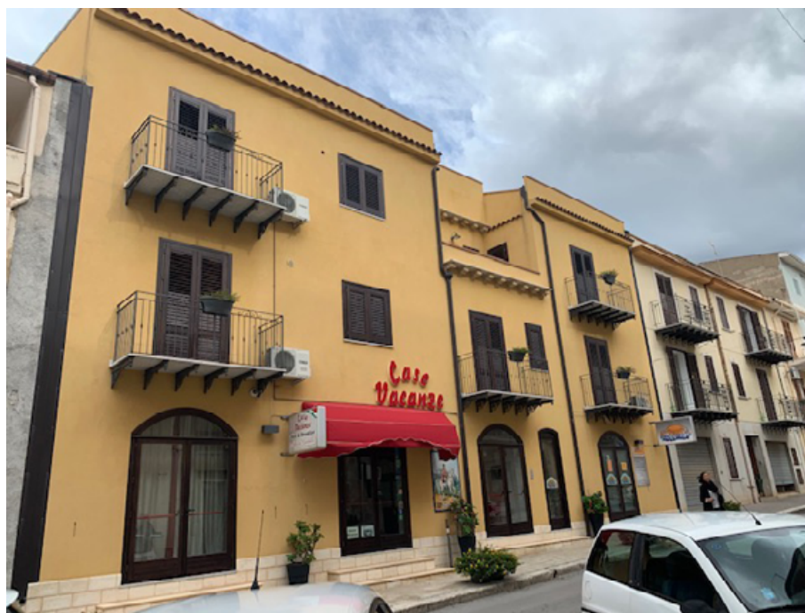
Foto 1. Prospetto dell'intero fabbricato su via Roma.
