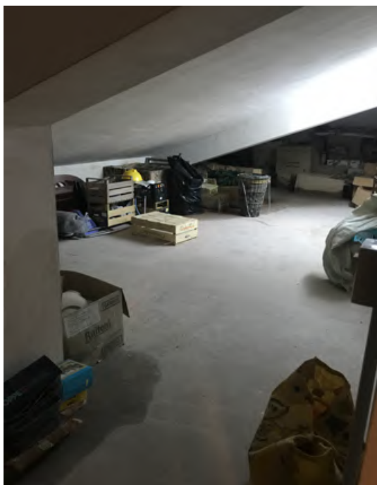
Foto 50. Locale deposito a sud ovest.
