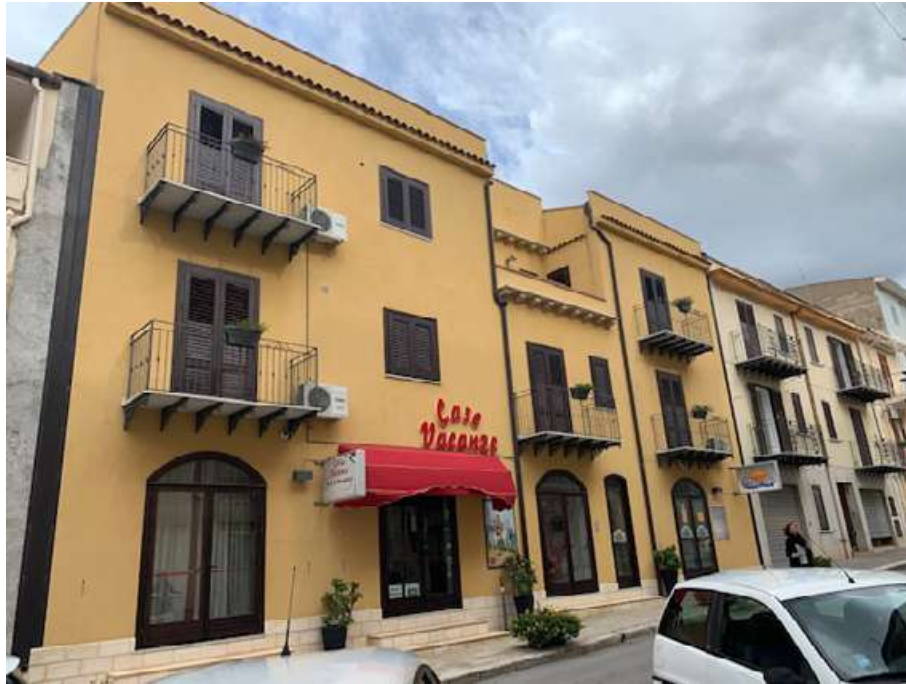
Foto 1. Prospetto dell'intero fabbricato su via Roma.
