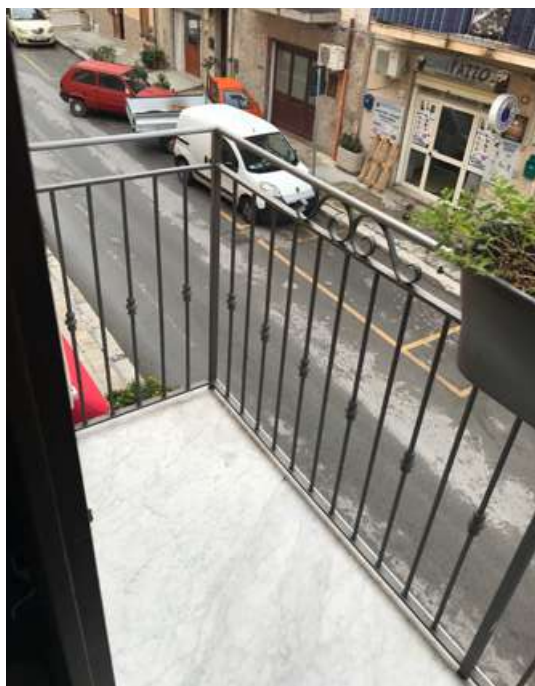
Foto 24. Balcone tipo prospiciente su via Roma.
