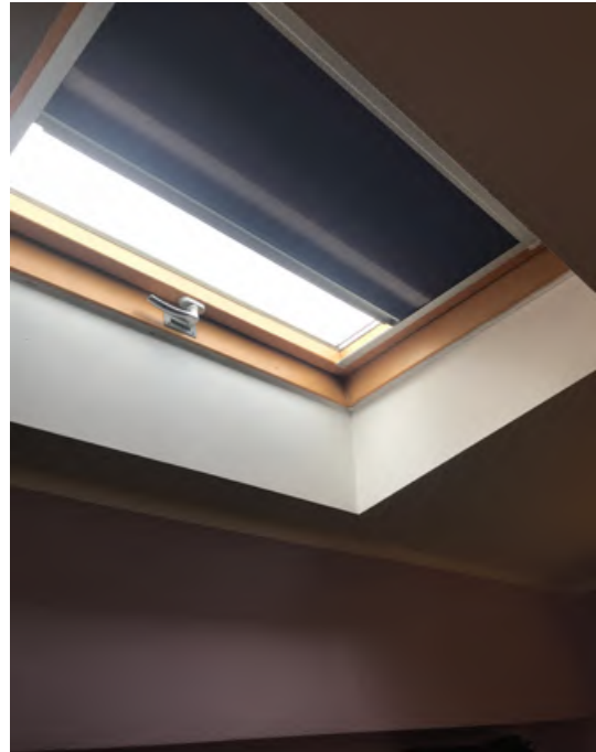
Foto 53. Lucernario tipo realizzato nella copertura del fabbricato all'interno dei SUB 16 e 17.
