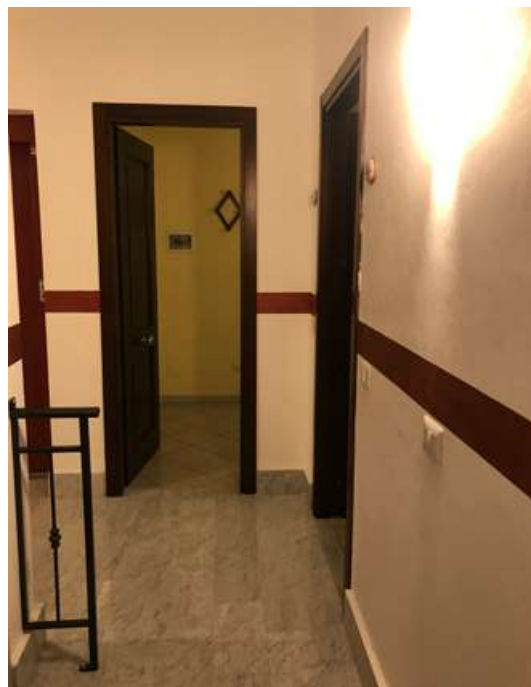
Foto 13. Corridoio di disimpegno agli appartamenti.
