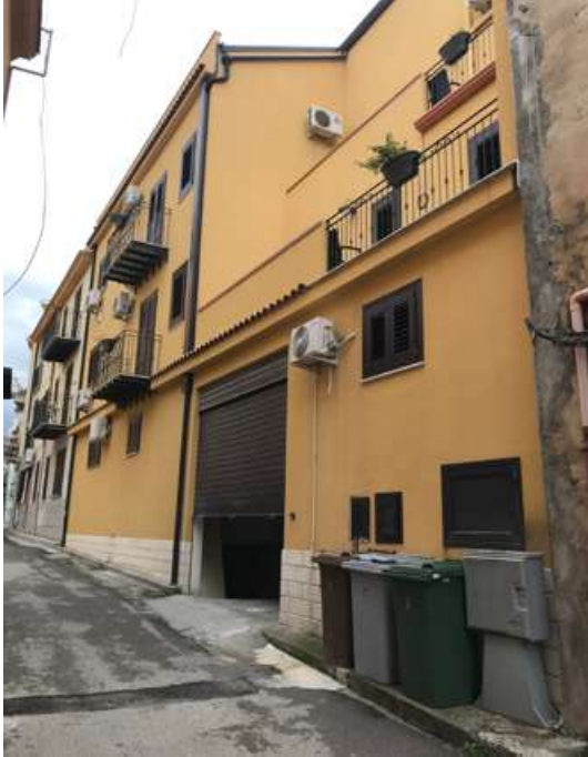
Foto 4. Retroprospetto del fabbricato e saracinesca d'ingresso al garage.
