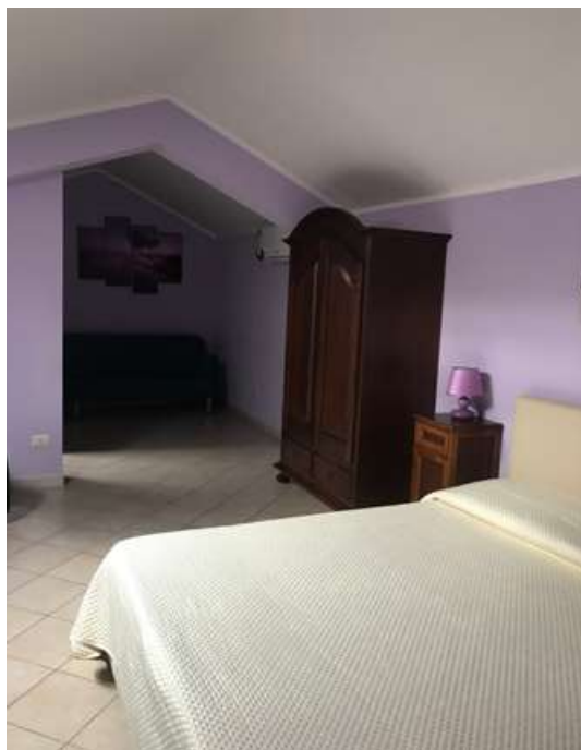
Foto 54. SUB 16. Locale deposito adibito a camera da letto.
