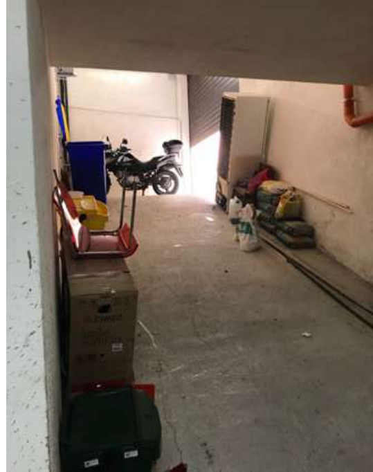
Foto 5. Rampa carrabile d'accesso al garage.
