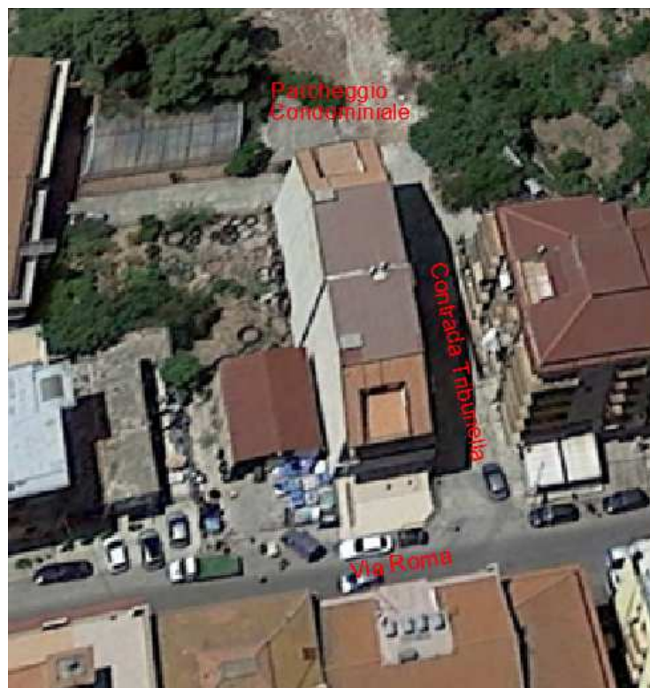
Foto 4 - Immagine del fabbricato
