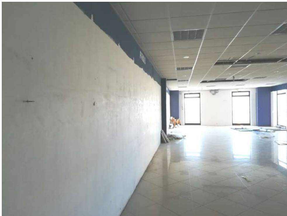
Foto 16- Interni del piano seminterrato
