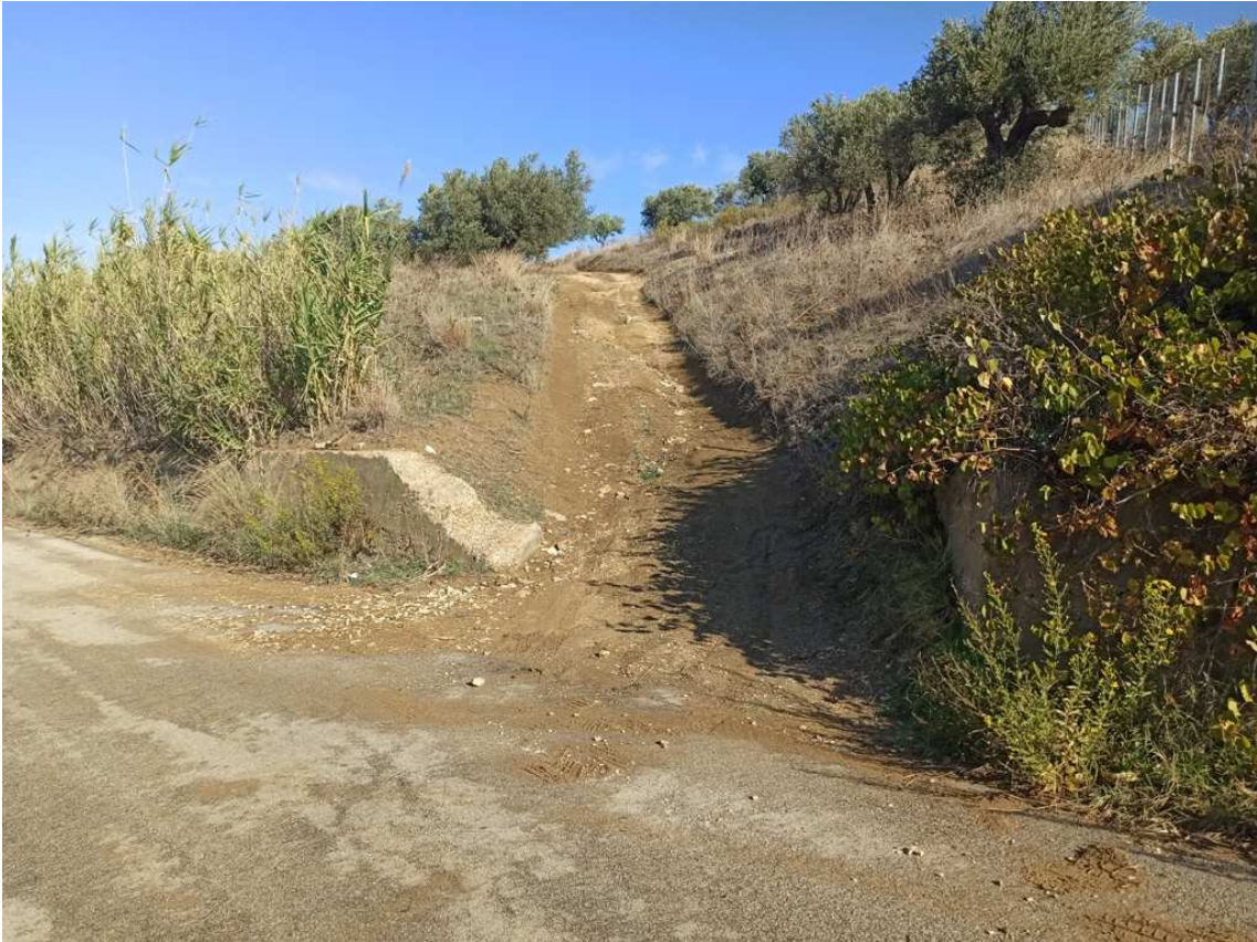
Foto 1 – Stradella interpodereale di accesso al lotto
