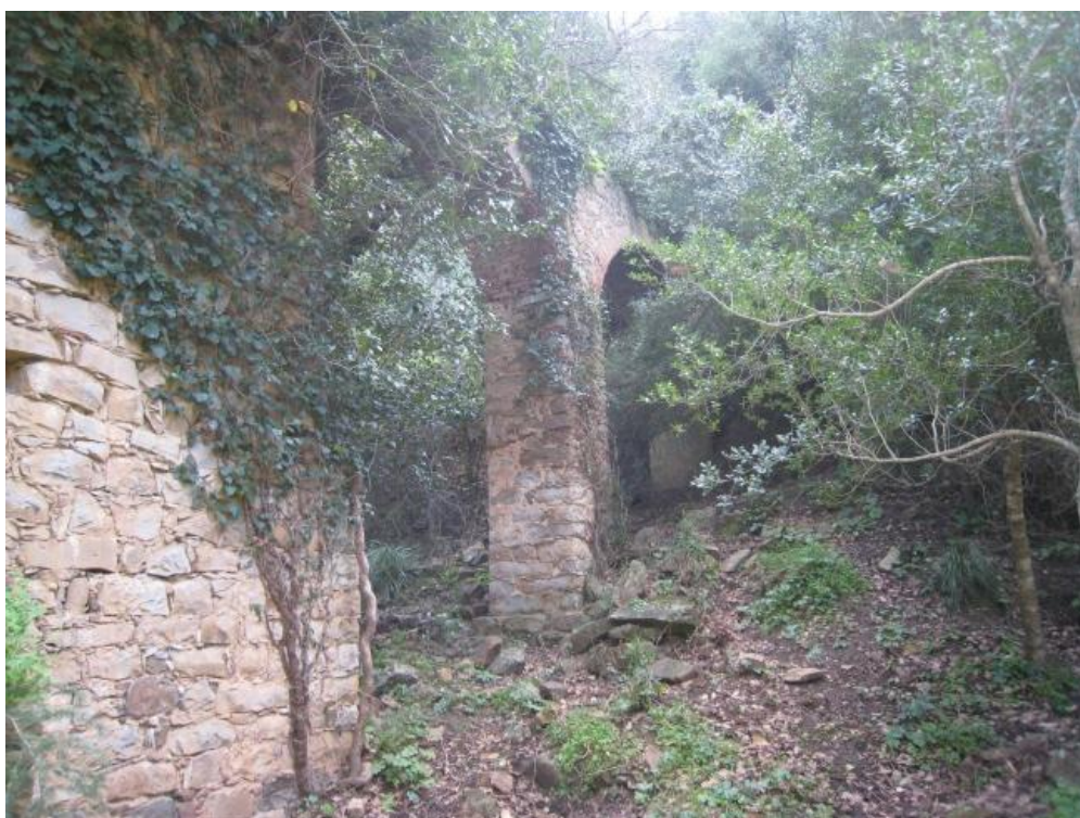
Foto n. 85. Le arcate che sorreggevano la condotta idrica.
