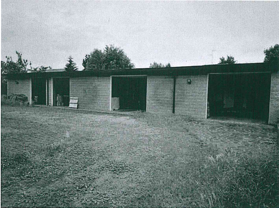
Vista esterna piano terra: deposito/autorimessa.
