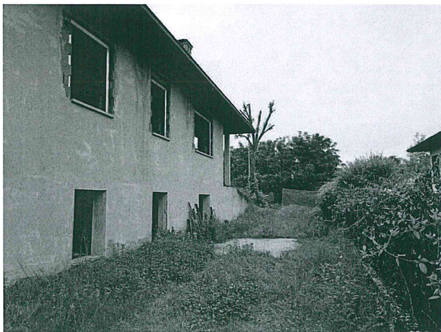
Vista esterna lato ovest.
