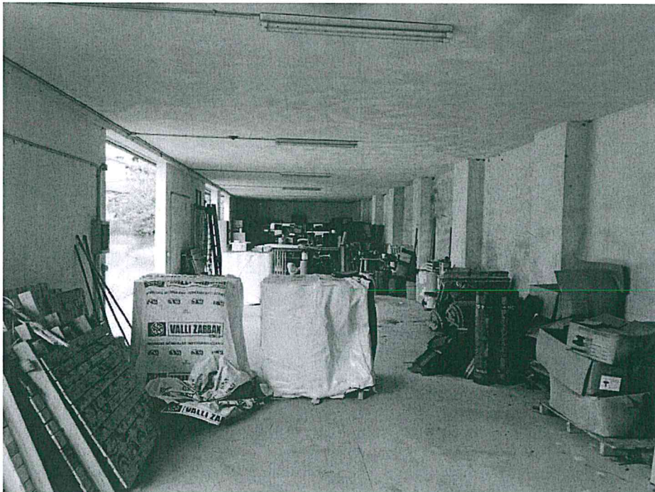
Vista interna piano terra: deposito/autorimessa.
