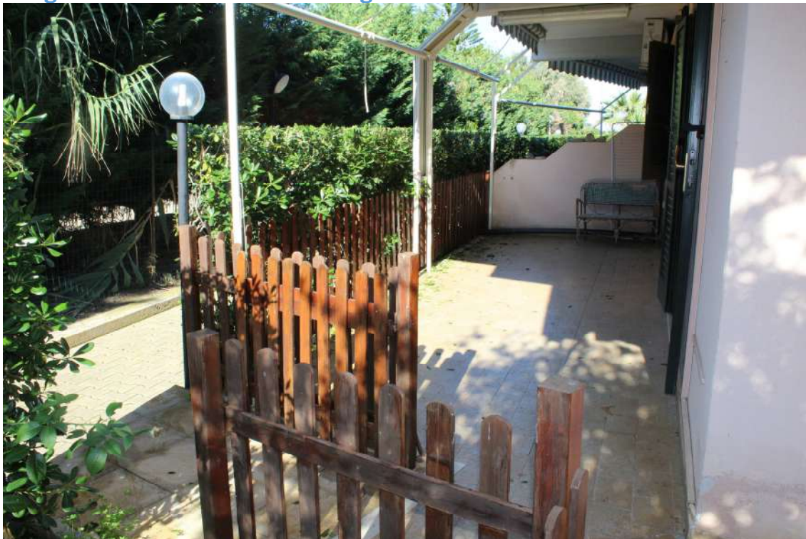
FOTO n°7 – UNITA' IMMOBILIARE facente parte del complesso “Agave Residence” sito in Campofelice di Roccella (Pa), Contrada Pistavecchia, Viale Himera n°1, edificio “A”, p.t.. N.C.E.U. Foglio 1, part. 1240, sub. 2. Spazio esterno di pertinenza esposto ad ovest.
