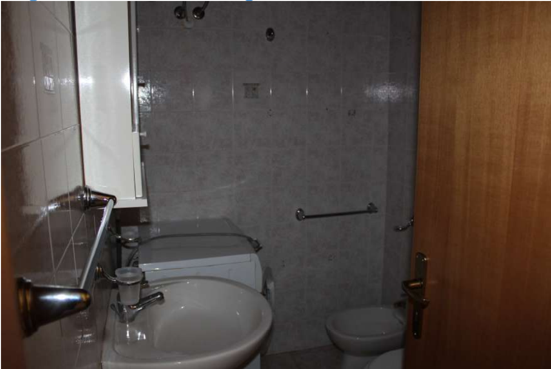
FOTO n°17 – UNITA' IMMOBILIARE facente parte del complesso “Agave Residence” sito in Campofelice di Roccella (Pa), Contrada Pistavecchia, Viale Himera n°1, edificio “A”, p.t.. N.C.E.U. Foglio 1, part. 1240, sub. 2. Vano w.c. intercluso.
