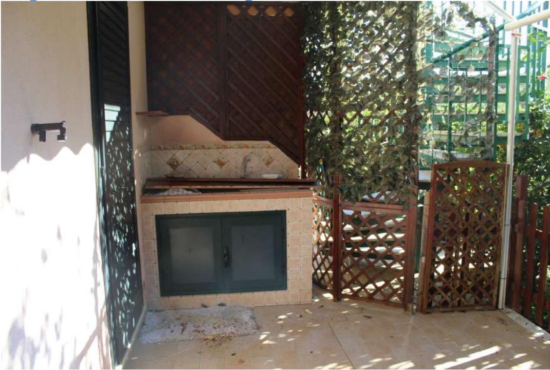
FOTO n°9 – UNITA' IMMOBILIARE facente parte del complesso “Agave Residence” sito in Campofelice di Roccella (Pa), Contrada Pistavecchia, Viale Himera n°1, edificio “A”, p.t.. N.C.E.U. Foglio 1, part. 1240, sub. 2. Spazio esterno di pertinenza esposto a sud.
