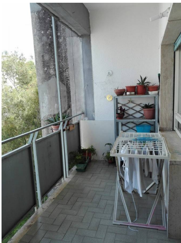
Foto 05 - Balcone lato Nord-Est
