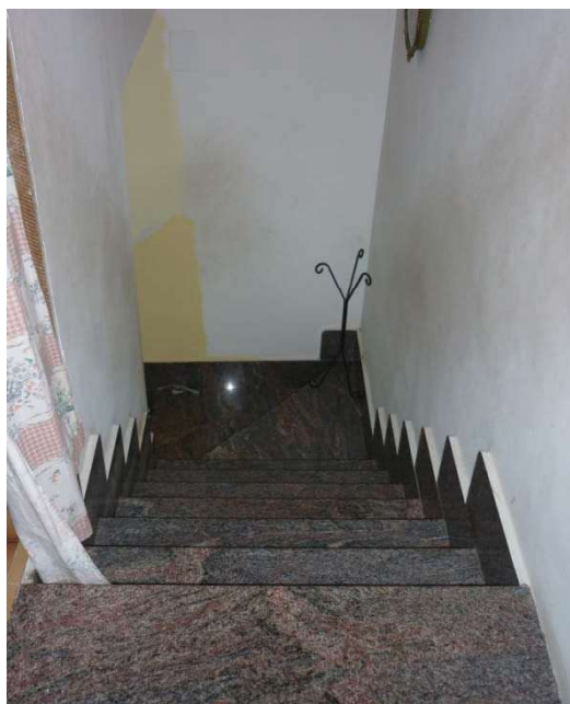
Scala di collegamento dal P.2° al sottotetto
