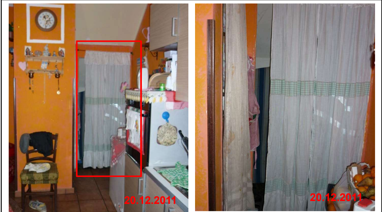
Accesso al sottoscala dal GARAGE
