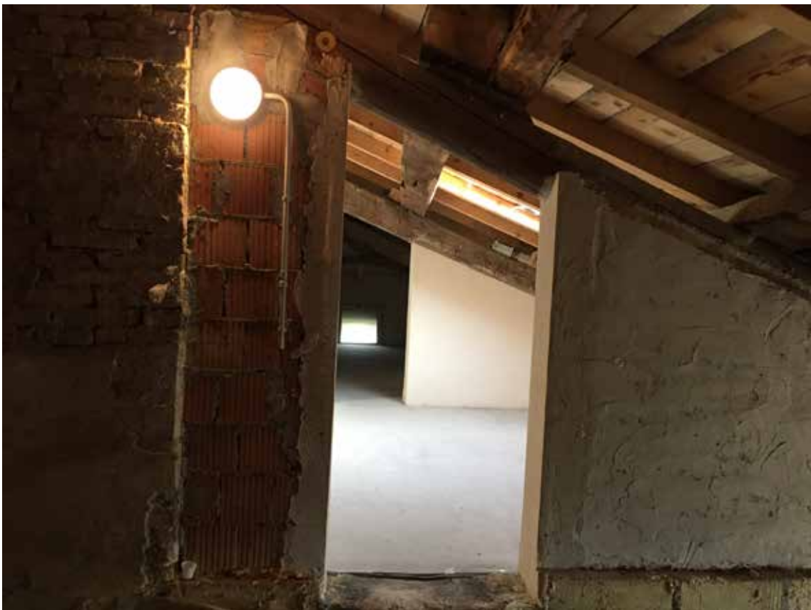
foto 22 - vista interna soffitta
