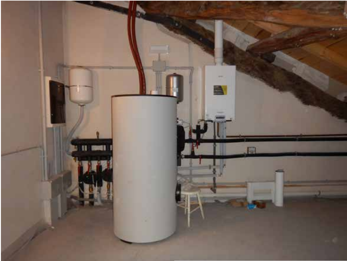
foto 21 - vista interna soffitta
