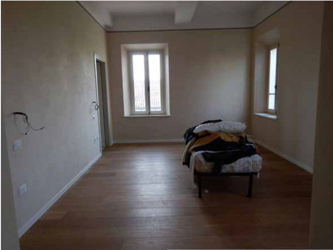
foto 19 - vista interna piano primo
