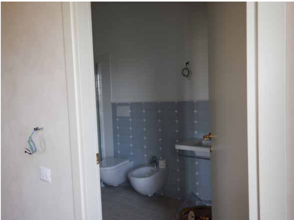
foto 20 - vista interna piano primo
