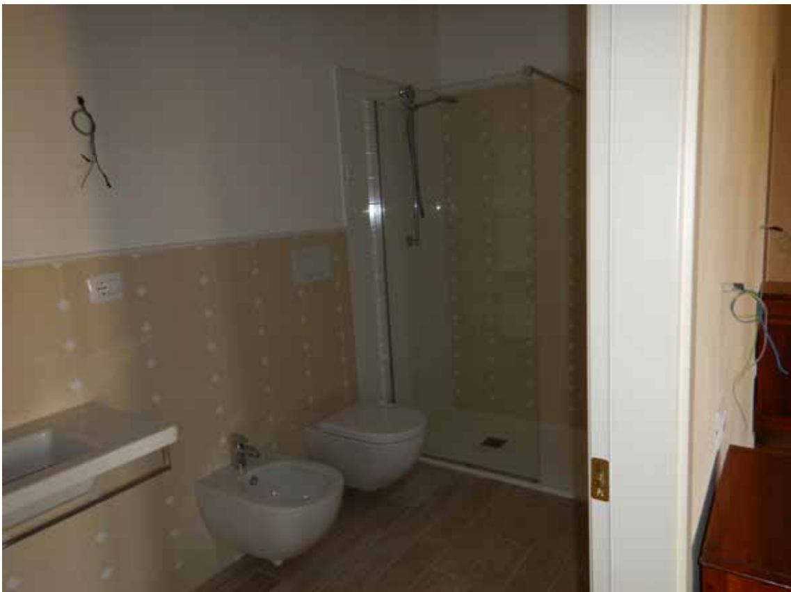
foto 18 - vista interna piano primo
