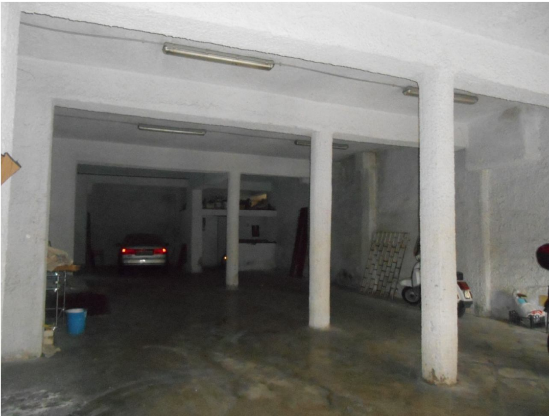
FOTO 4 – Ambiente principale pilastro
