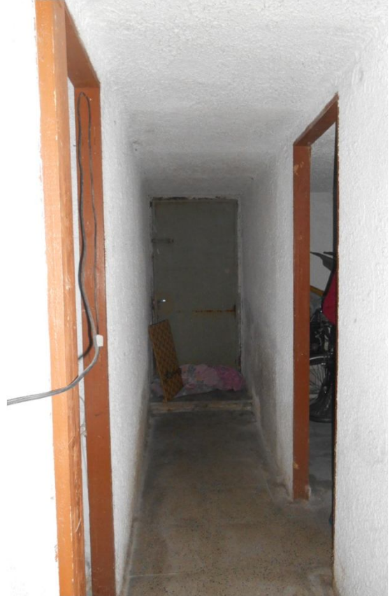
FOTO 8 – corridoio e porta in ferro sul pozzo luce
