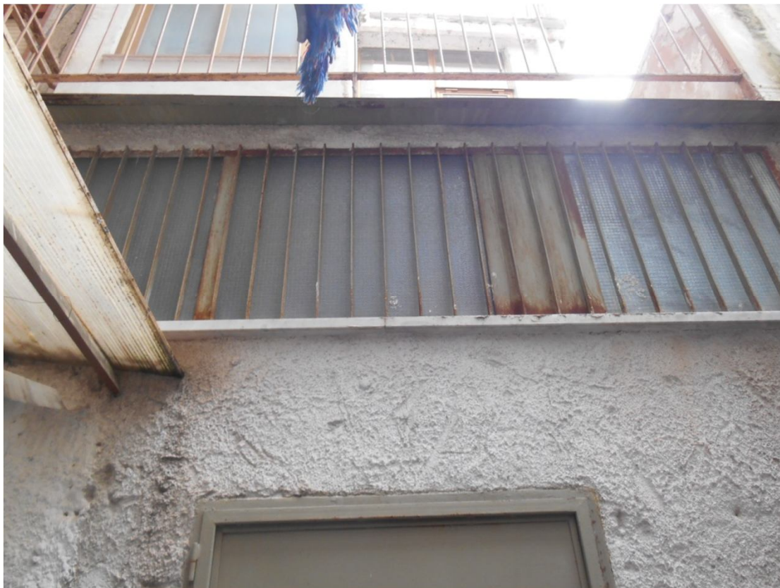
FOTO 11 – Muro d'ambito tra magazzino e pozzo luce
