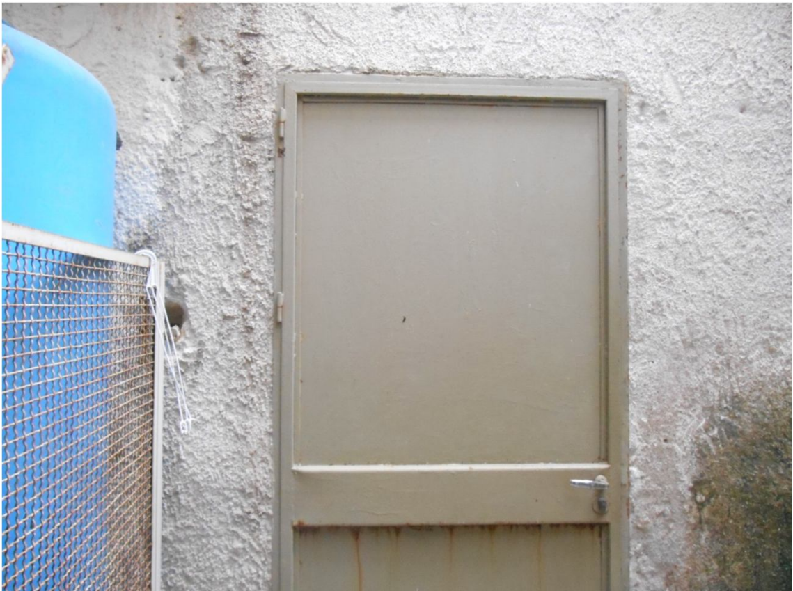
FOTO 9 – Porta in ferro di collegamento pozzo luce-immobile A
