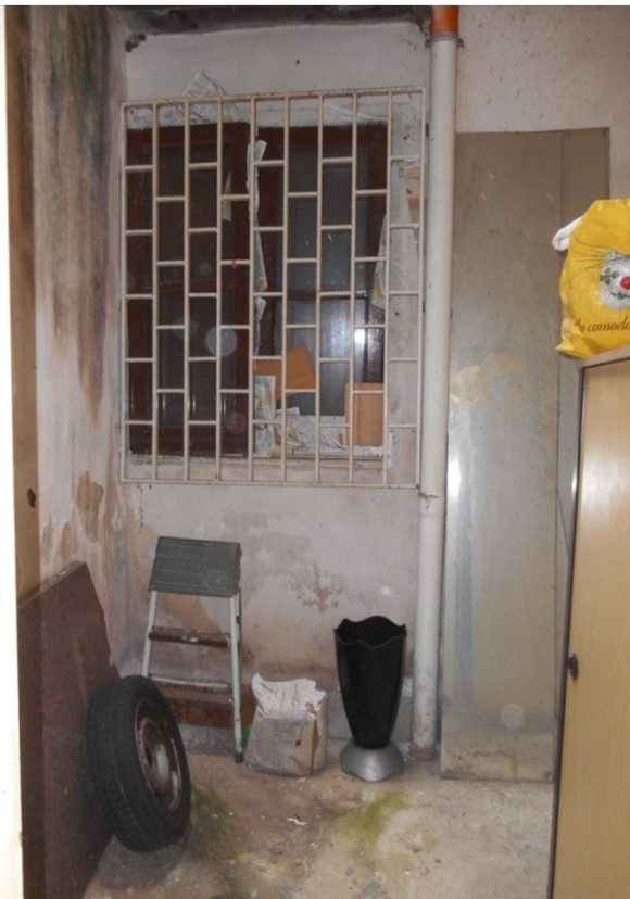
FOTO 12 – Pozzo luce su cui si affaccia cucina
