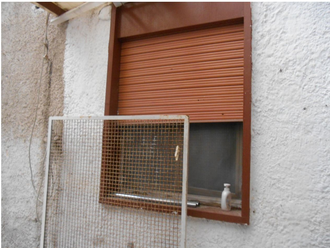
FOTO 19 – Finestra della ex camera da letto
